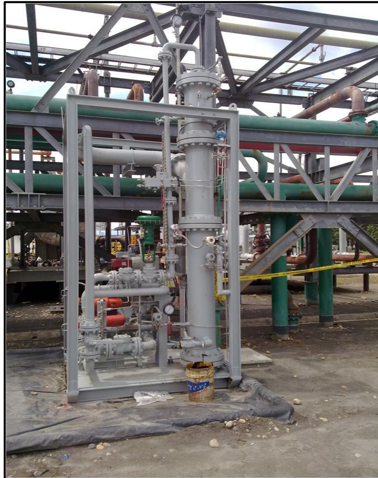
Figura 27. Separador de prueba GLCC
