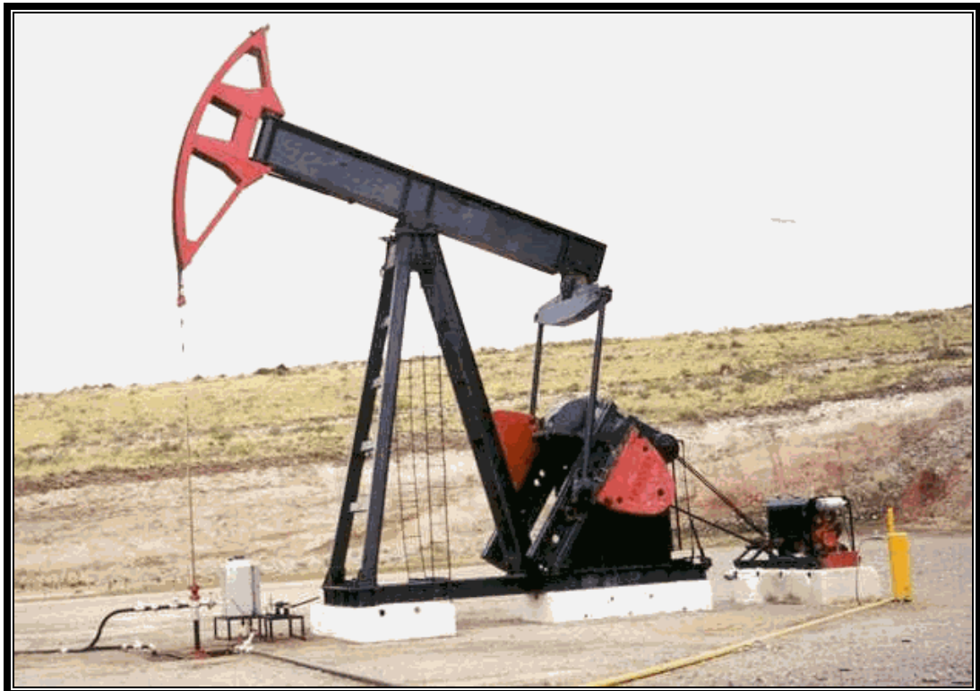
Figura N° 5. El bombeo mecánico
