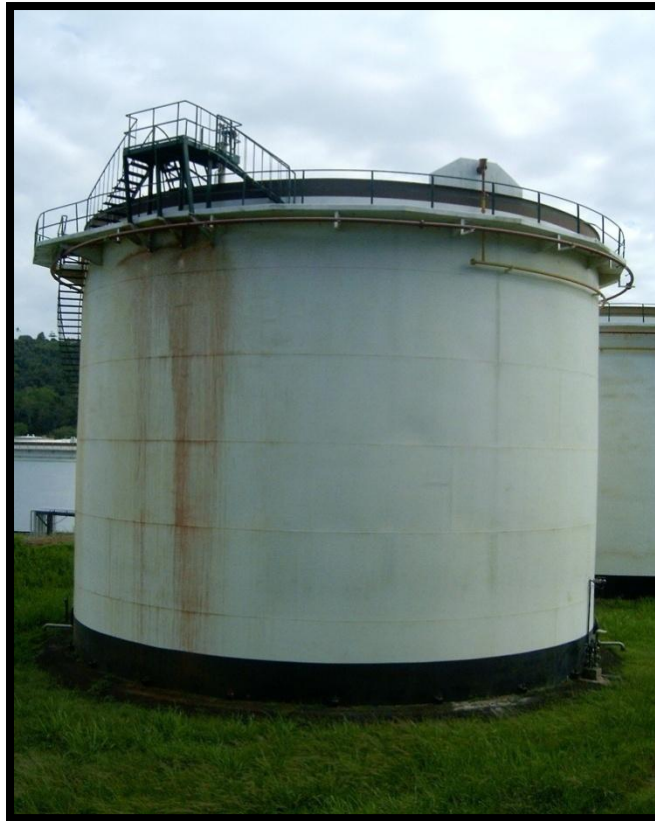
Figura.2.19 Tanque usado para el almacenamiento de diesel Premium en la REE.
