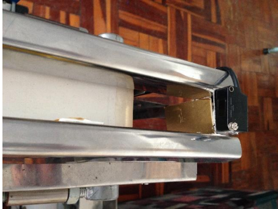
Figura 4.49. Sensor de presencia PS-T1M botellas A, instalado (Loaiza, 2014)
