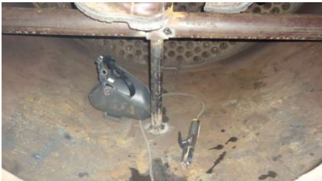
FIGURA28. Fotografía de los trabajos de construcción interna
