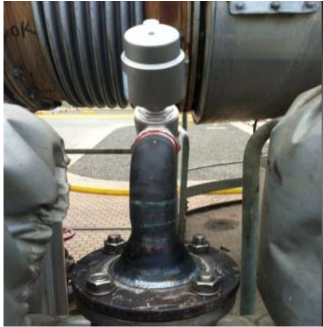
FIGURA 42. Fotografía de la Electroválvula de control
