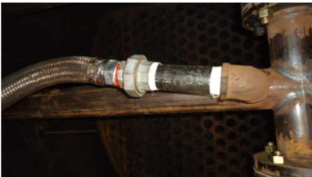
FIGURA34. Fotografía de los trabajos de construcción del soplador interno (7)
