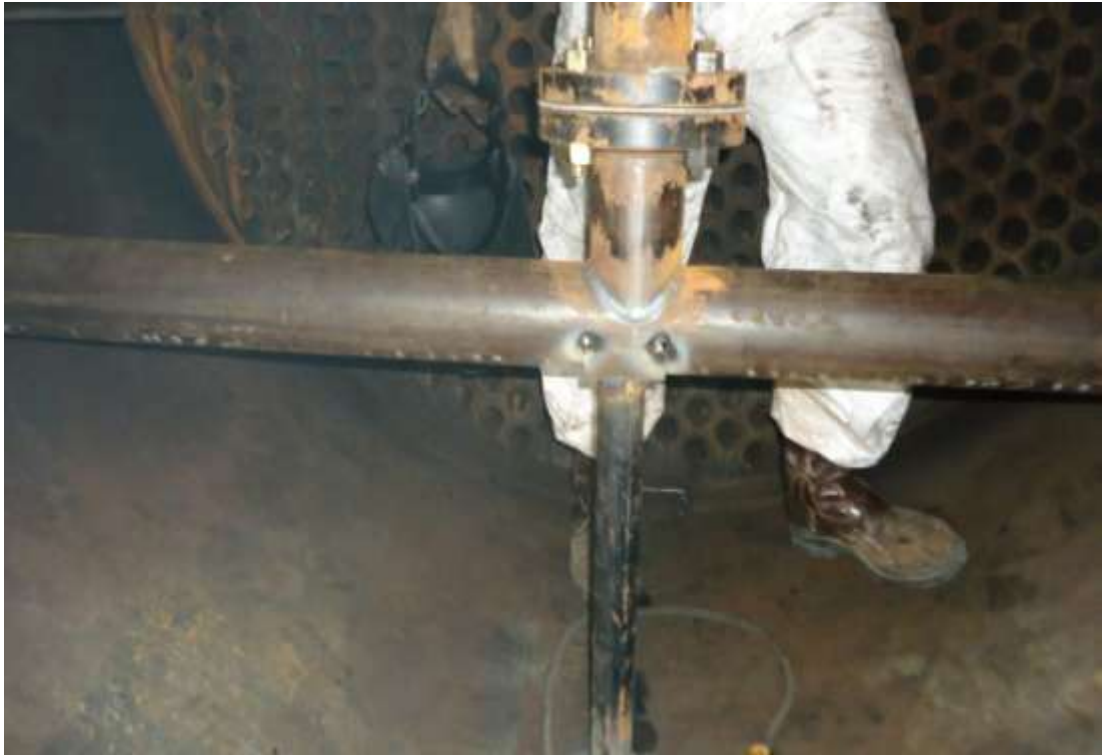
FIGURA29. Fotografía de los trabajos de construcción del soplador interno (2)
