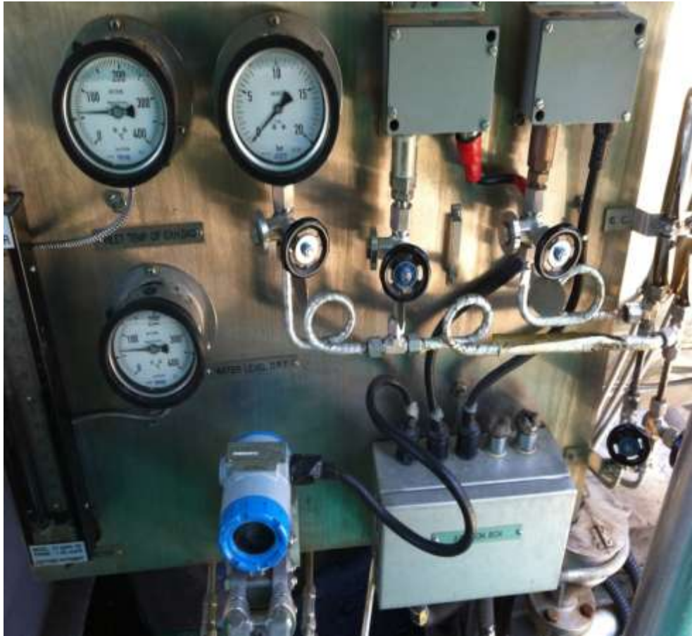
FIGURA9. Fotografía de la Instrumentación Caldera
