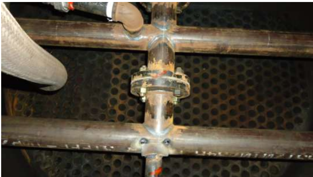
FIGURA33. Fotografía de los trabajos de construcción del soplador interno (6)
