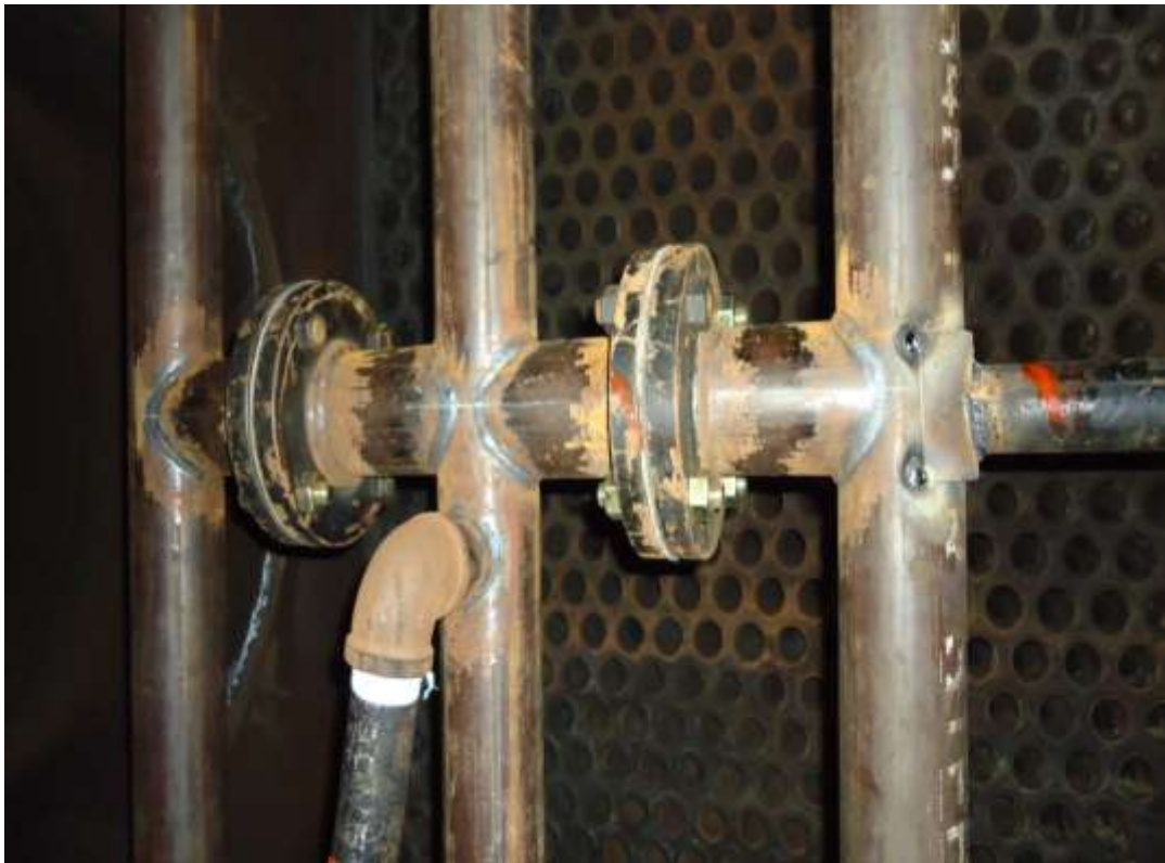
FIGURA32. Fotografía de los trabajos de construcción del soplador interno (5)
