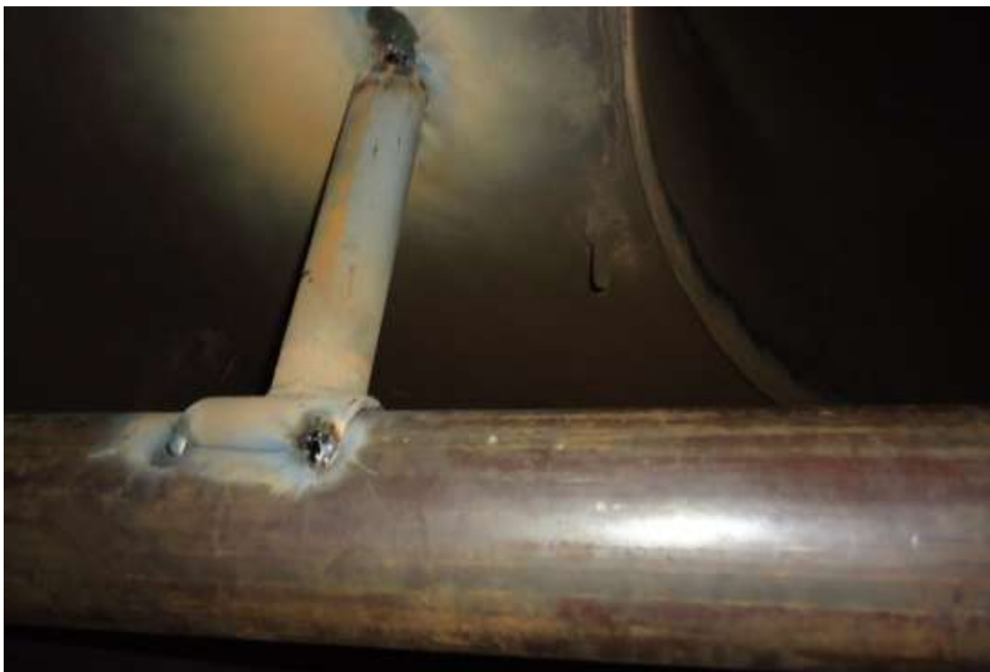
FIGURA 30.Fotografía de los trabajos de construcción del soplador interno (3)
