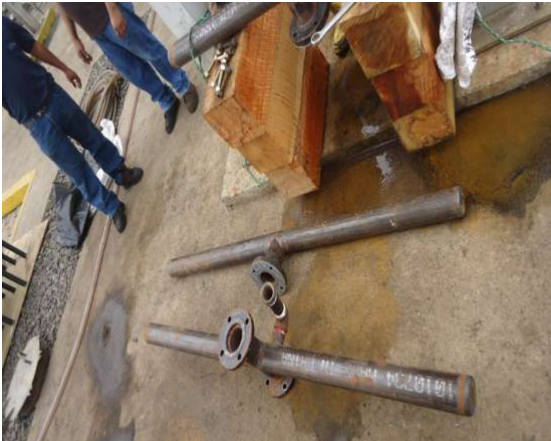
FIGURA19. Fotografía del proceso de construcción del soplador
