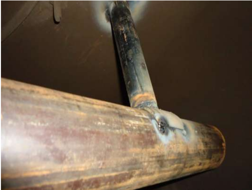
FIGURA31. Fotografía de los trabajos de construcción del soplador interno (4)
