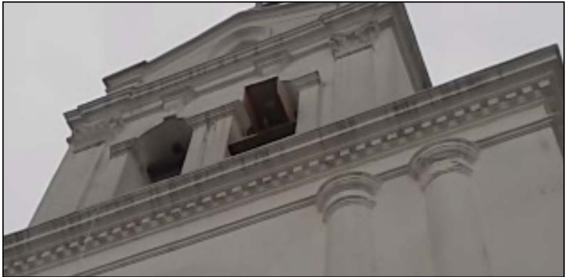
Figura 74: Colocación de Cubierta
