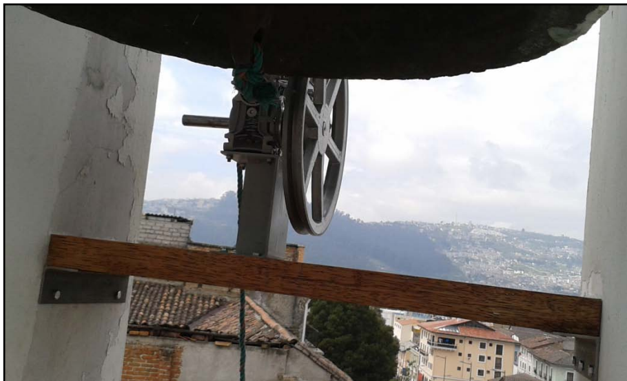
Figura 73: Colocación del motor sobre soporte de madera
