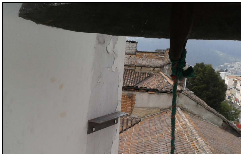
Figura 71: Colocación de ángulos para soporte
