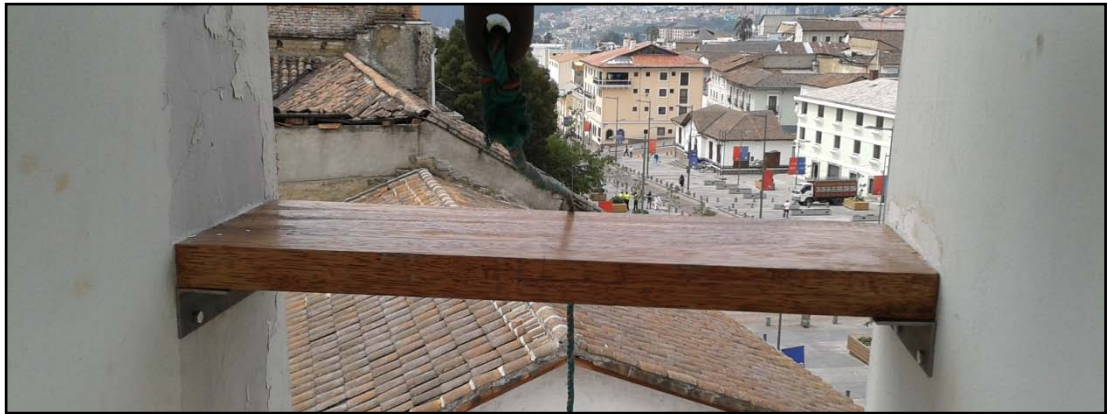
Figura 72: Colocación de soporte de madera
