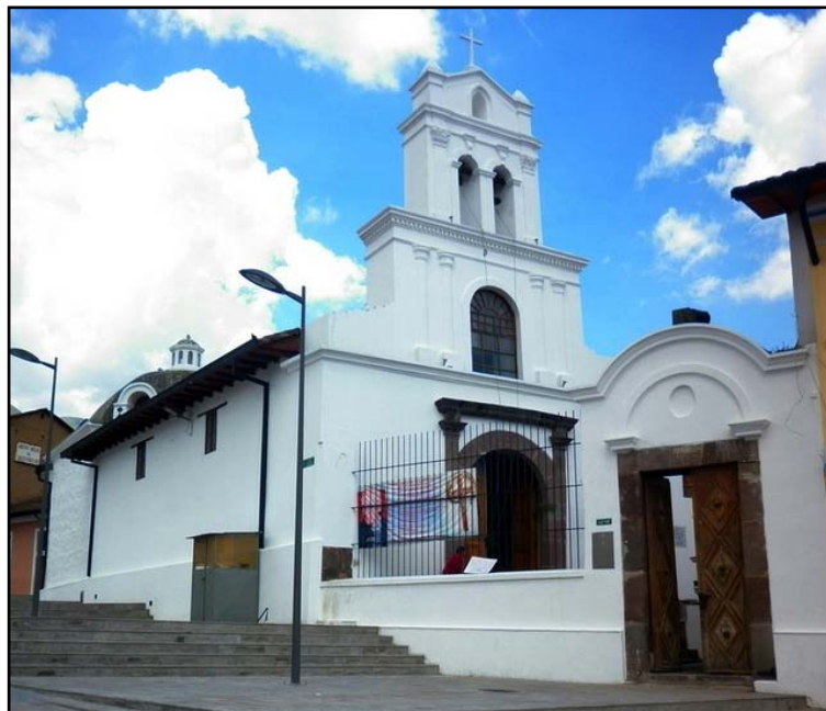
Figura 1: Exterior de la Iglesia del Robo
