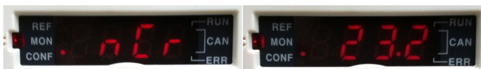
Figura 83. Corriente nominal del motor.
