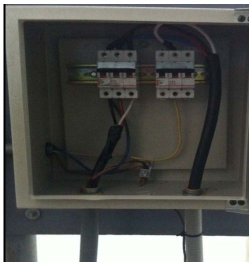
Figura 75. Acometidas trifásica y monofásica.
