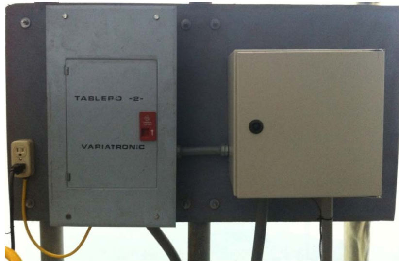
Figura 74. Acometidas trifásica y monofásica.
