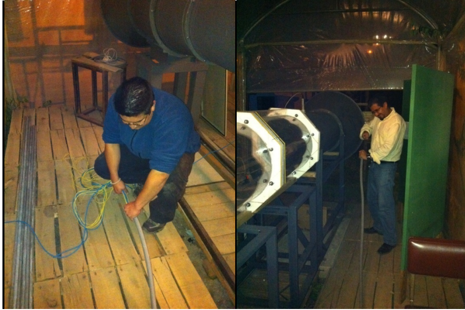
Figura 76. Pasando cable por manguera para las conexiones.
