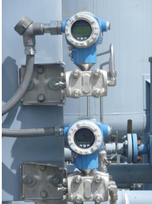
Figura N° 2. 7 Transmisor de presión Deltabar PMC71-TAC1HBRADAA
