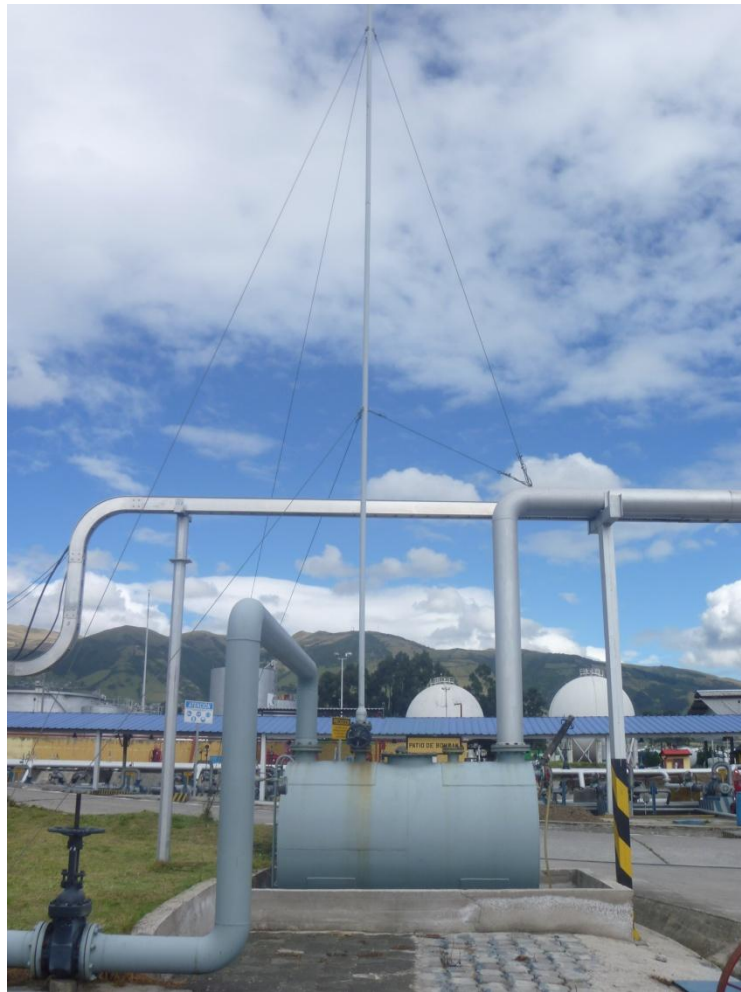
Figura N° 2. 22 Válvula Manual en la entrada del Sistema DRYVac™
