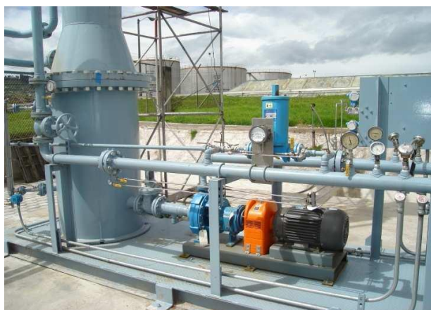
Figura N° 2. 33 Bomba de Retorno P-301
