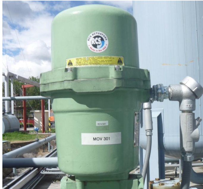
Figura N° 2. 14 Actuador RCS SUR-49-5-CW
