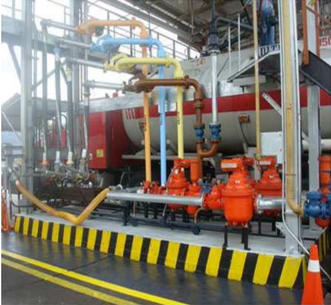
Figura N° 2. 3 Carga ventral (DRYVAC)
