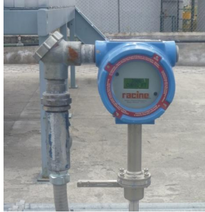
Figura N° 2. 8 Transmisor de flujo tipo vortex RNG12NPTSDNS
