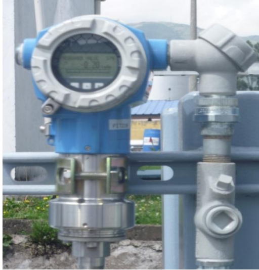
Figura N° 2. 6 Transmisor de presión Cerabar PMC71-TAC1HBRADAA
