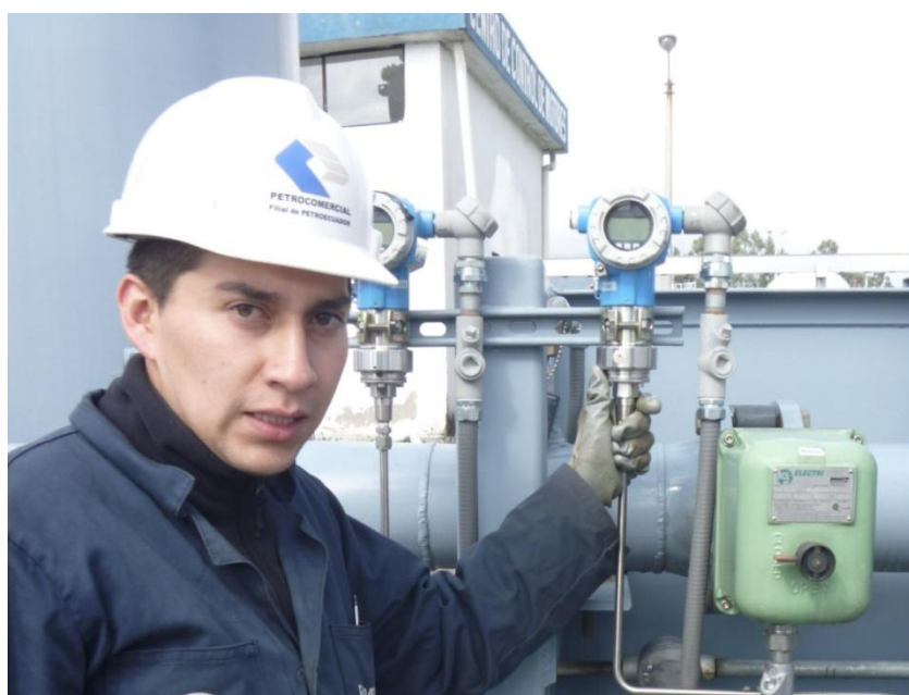
Figura N° 4. 11 Montaje del transmisor.
