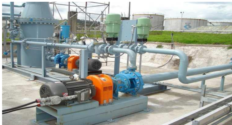
Figura N° 2. 35 Válvulas ESD (MOV 201/301)
