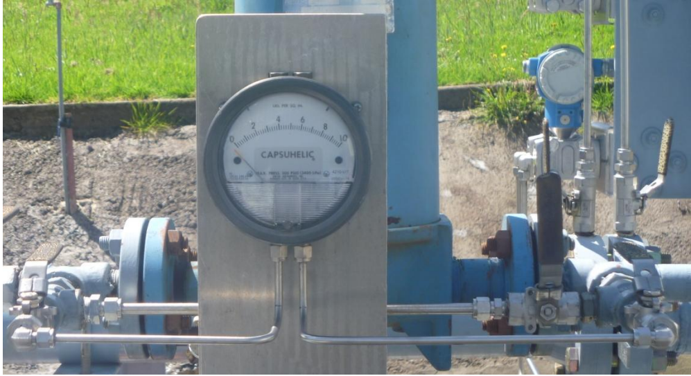
Figura N° 2. 21 Manómetro capsuhelic DPI-202
