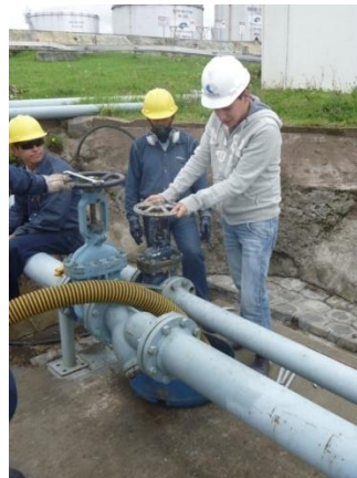
Figura N° 4. 19 Limpieza de Sedimentos en la tubería
