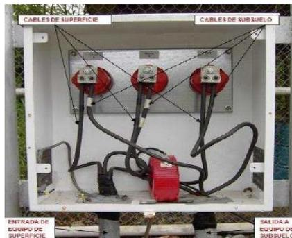
**Figura 2.31.** Caja de Venteo o de Empalme
