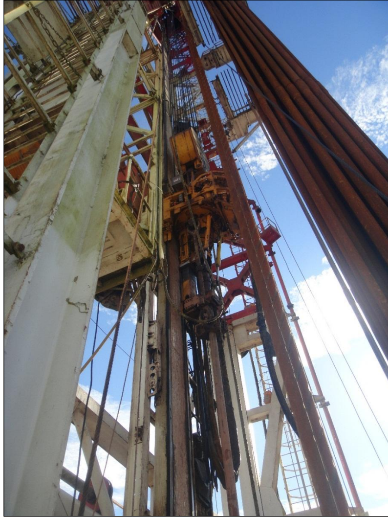
Figura 22. Sistema de Levantamiento visto desde la mesa de la torre de perforación (líneas, bloque viajero gancho, elevadores y brazos).
