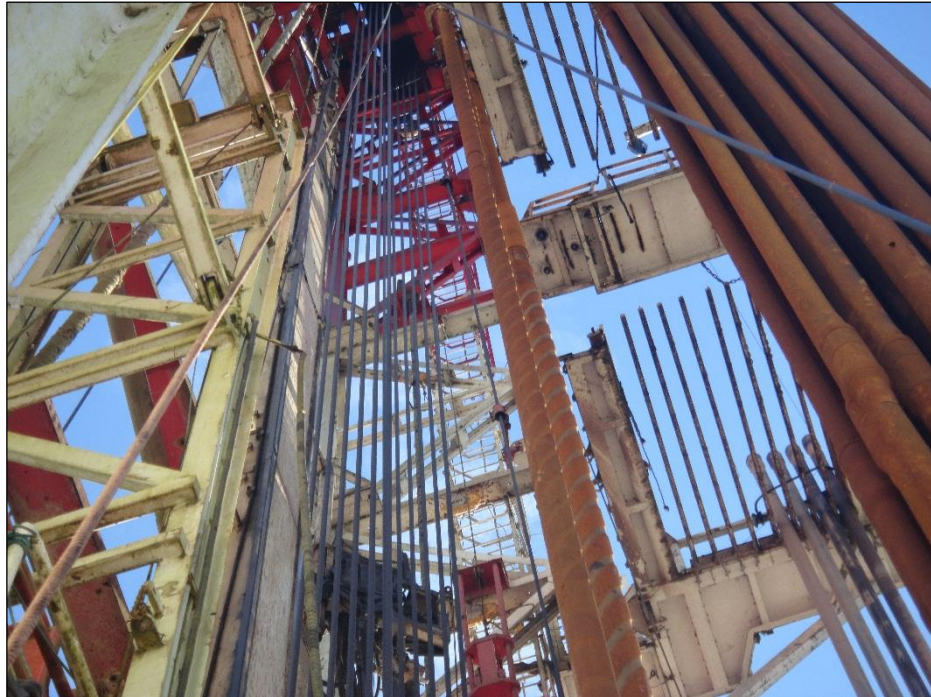
Figura 23. Líneas de acero del sistema de izaje de la torre de perforación.
