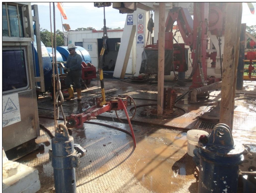
Figura 24. Mesa de la torre de perforación, inspección de equipos.
