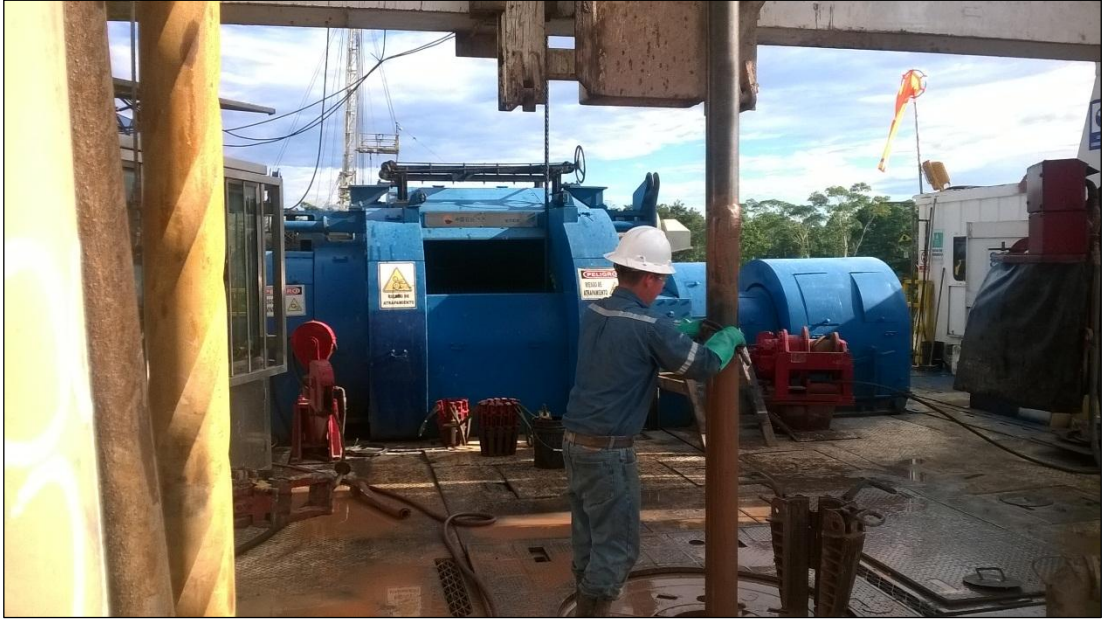
Figura 26. Mesa de la torre de perforación: limpieza y orden en el área.
