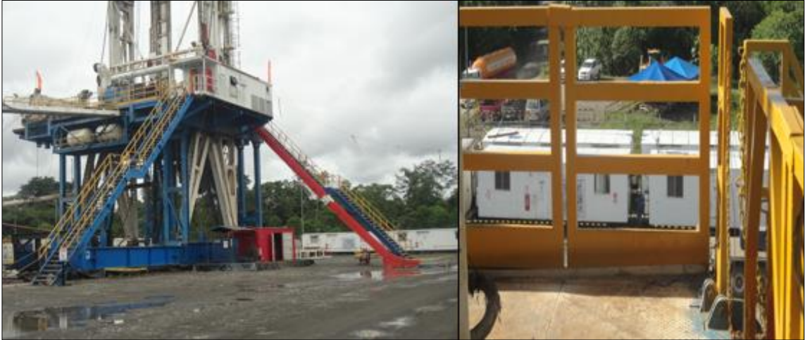
Figura 25. Escaleras de acceso, anclajes y pines con cupillas de seguridad.
