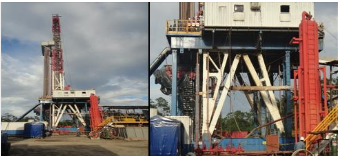
Figura 23. Vista lateral del mástil y la subestructura.
