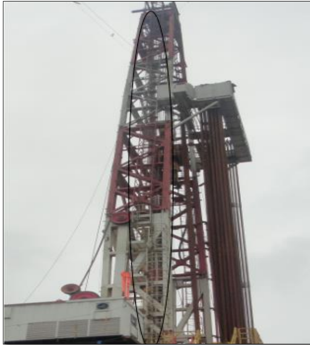
Figura 17. Escalera del mástil de perforación.
