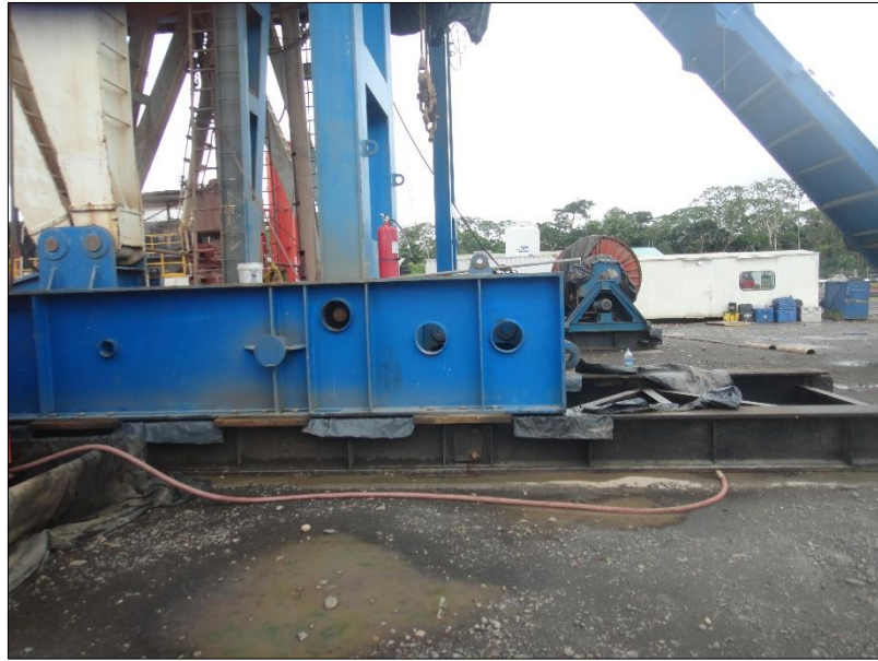
Figura 35. Cimientos y bases de la subestructura.
