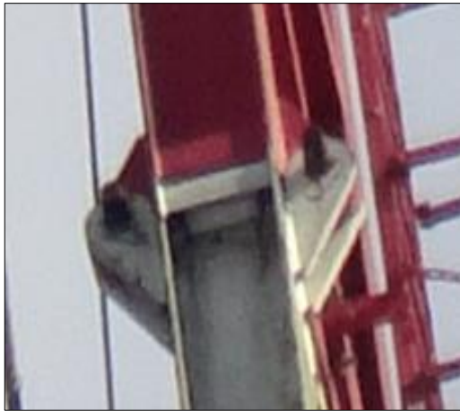
Figura 38. Orejas de anclaje que une secciones de un mástil.
