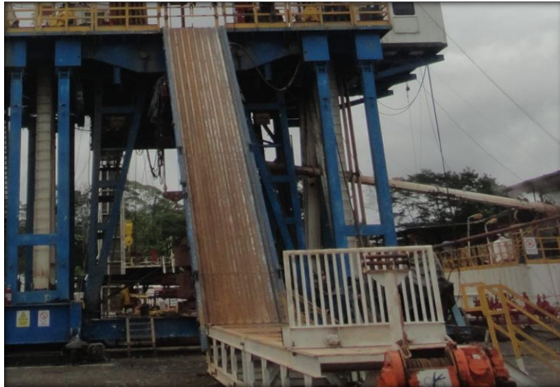
Figura 13. Rampa o planchada.
