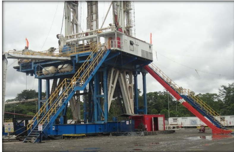
Figura 14. Escaleras de acceso al piso o mesa del mástil.
