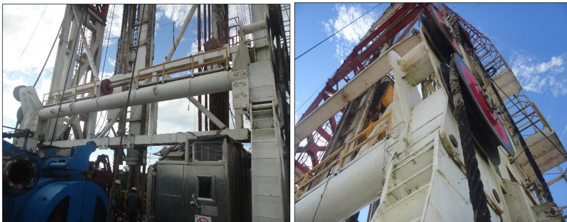
Figura 19. Cables de acero en el mecanismo de erección del mástil.
