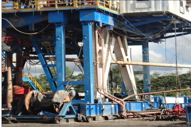
Figura 33. Columnas, largueros y travesaños de la subestructura.
