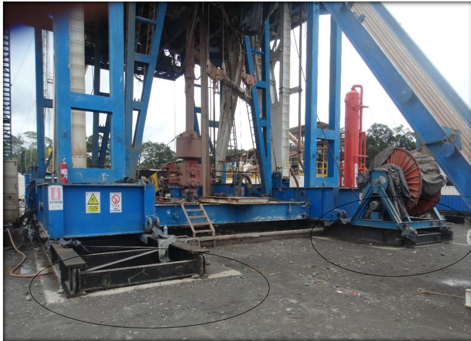
Figura 16. Cimientos de la torre de perforación.
