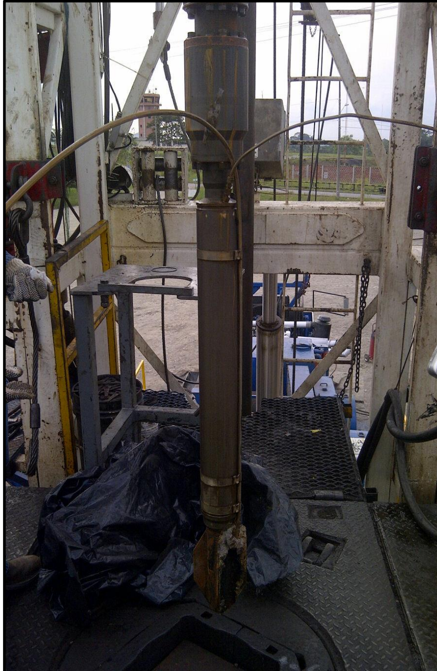
Figura 40. Bajando equipo ESPCP 130 D-3600. (Repsol, 2014).
