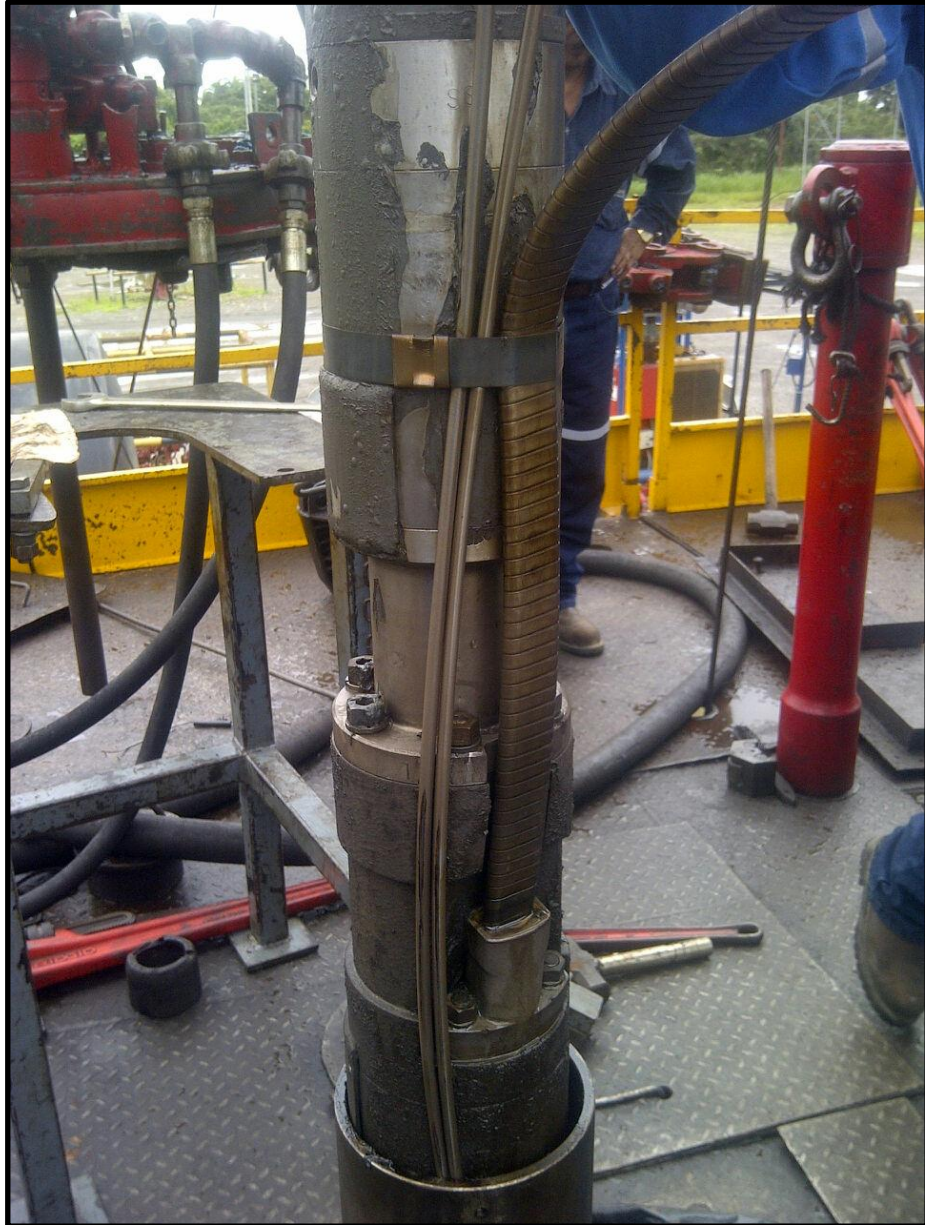
Figura 41. Bajando equipo ESPCP 130 D-3600. (Repsol, 2014).
