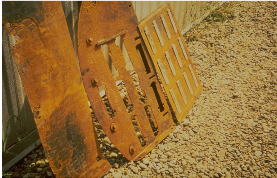
Figura 1. Corrosión General Fuente: (UTE, Ramos F, 2010)
