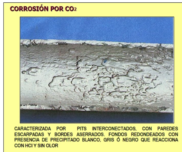
Figura 16. Corrosión por CO 2 .
