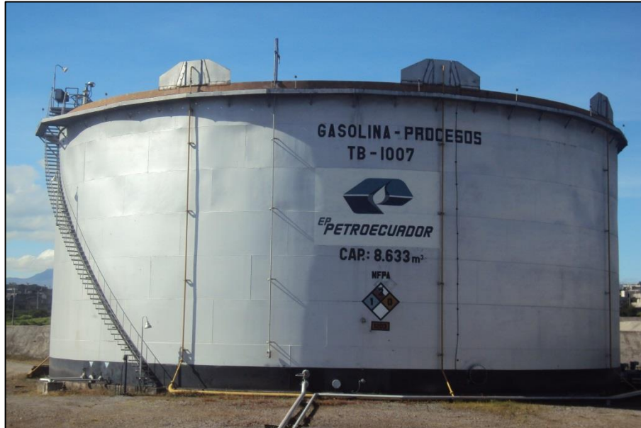
Figura 2.3 Tanque de techo Flotante TB-1007 almacenado con Gasolina-Procesos.
