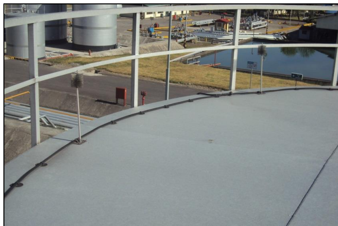
Figura 3.19 Instalación de Pararrayos en Tanque de Techo Fijo.
