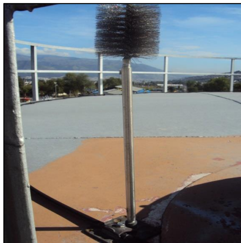
Figura 4.49 Instalación de un Conector Mecánico con un pararrayos a una bajada de tierra en el Tanque de Diésel Premium TB 1008.
