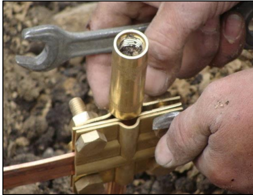
Figura 4.44 Cabeza del Electrodo de Tierra
