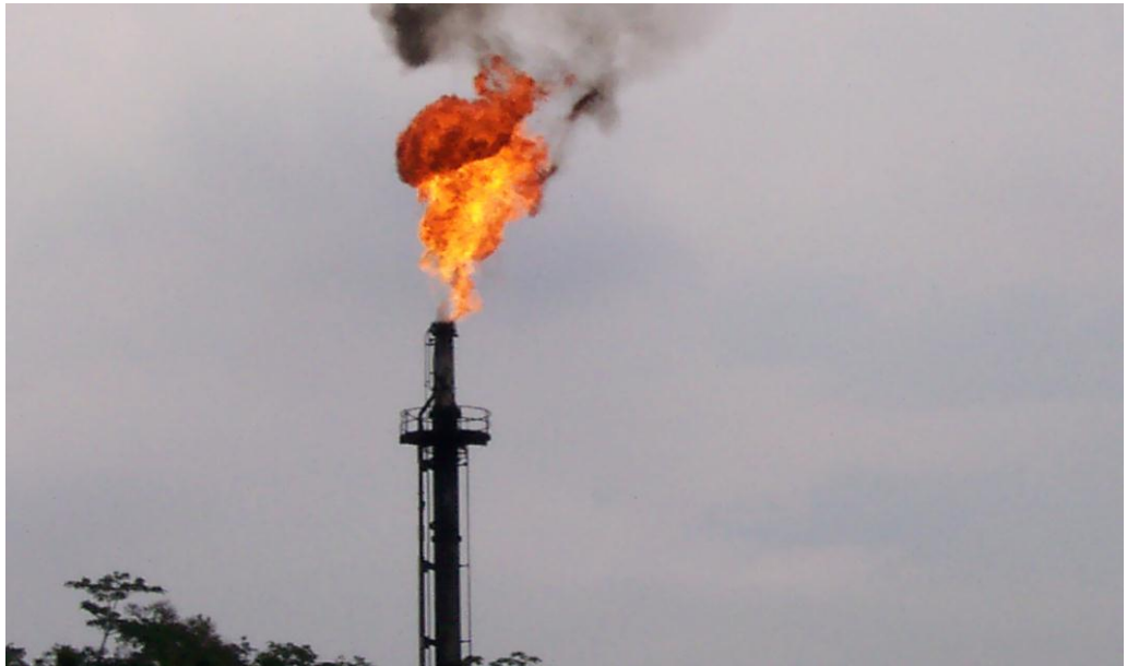
Figura 4. Quema de gas en la tea en la Refinería Estatal de Esmeraldas.
