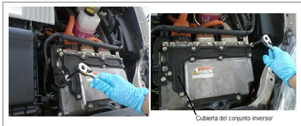
Figura 85. Desarmado de la cubierta de conjunto inversor
