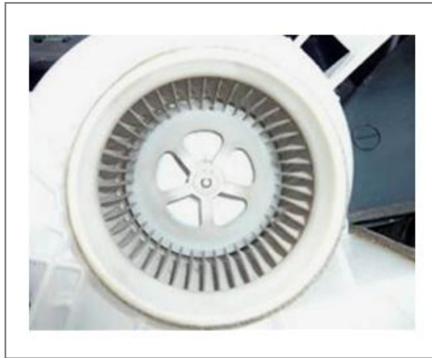
Figura 70. Soplador de refrigeración después de limpieza
