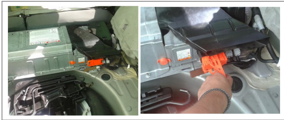
Figura 84. Enganchado de la toma de servicio o Jumper
