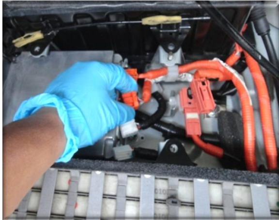
Ilustración 63: Desconexión de cables de alto voltaje.
