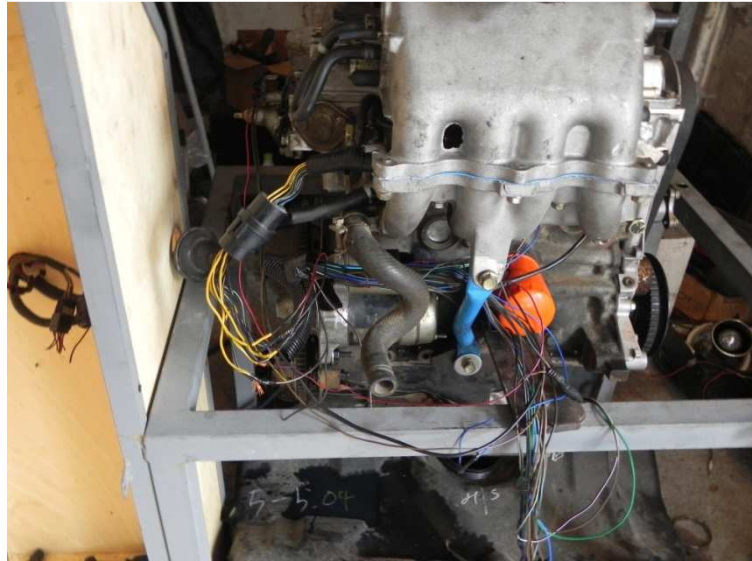
Figura 29. Construcción de bases y montaje del motor.
