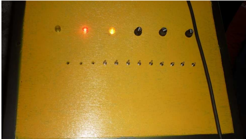
Figura 6. Comprobación del tablero de diagnóstico.
