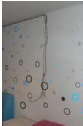
Sala de área vip. Cables vistos en paredes y pisos sucios.
