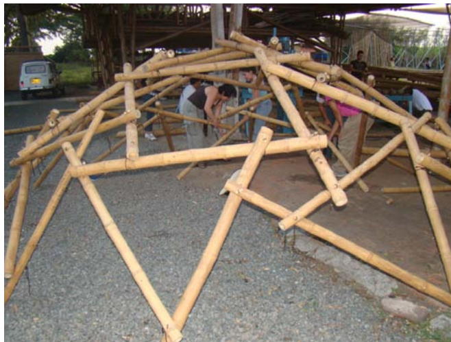
Semiesfera en guadua 0 8cm., diámetro total 6m, altura 1,80 Taller Ecobamboo, La Candelaria, Cali, Colombia, diciembre 2009, grupo UTE Diseño Interior, Prof. Arq. Ricardo De Leiva, Joerg Stamm
