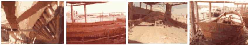
Una muestra de estructura transversal en sus distintas fases de construcción
