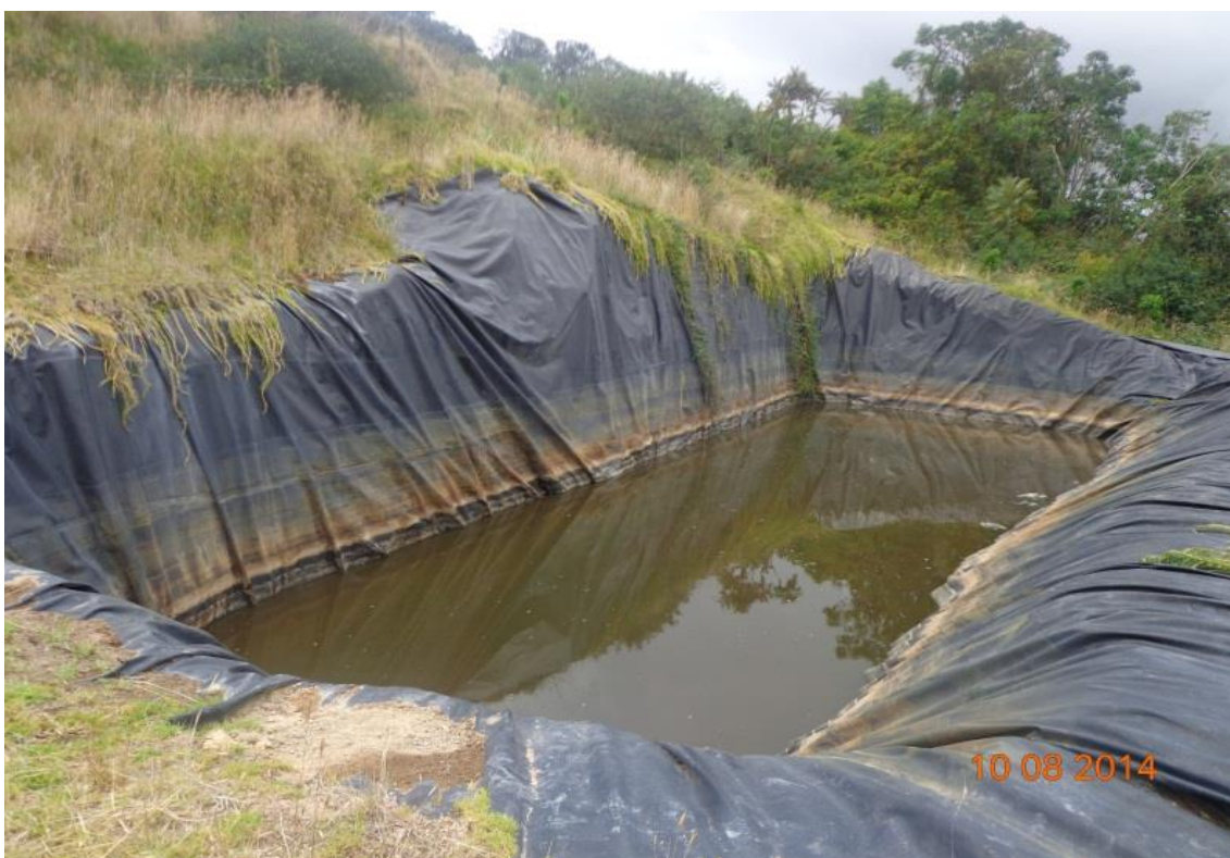
Figura 20. Foto de piscina de almacenamiento de lixiviados
