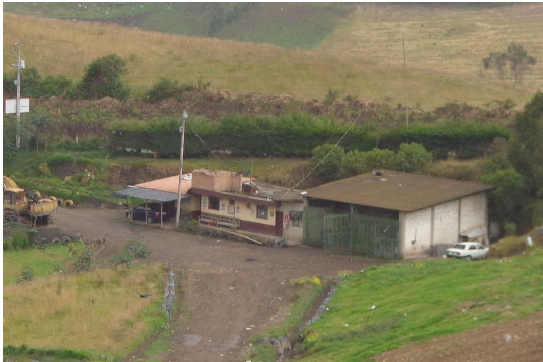
Figura 33. Foto de las instalaciones complementarias
