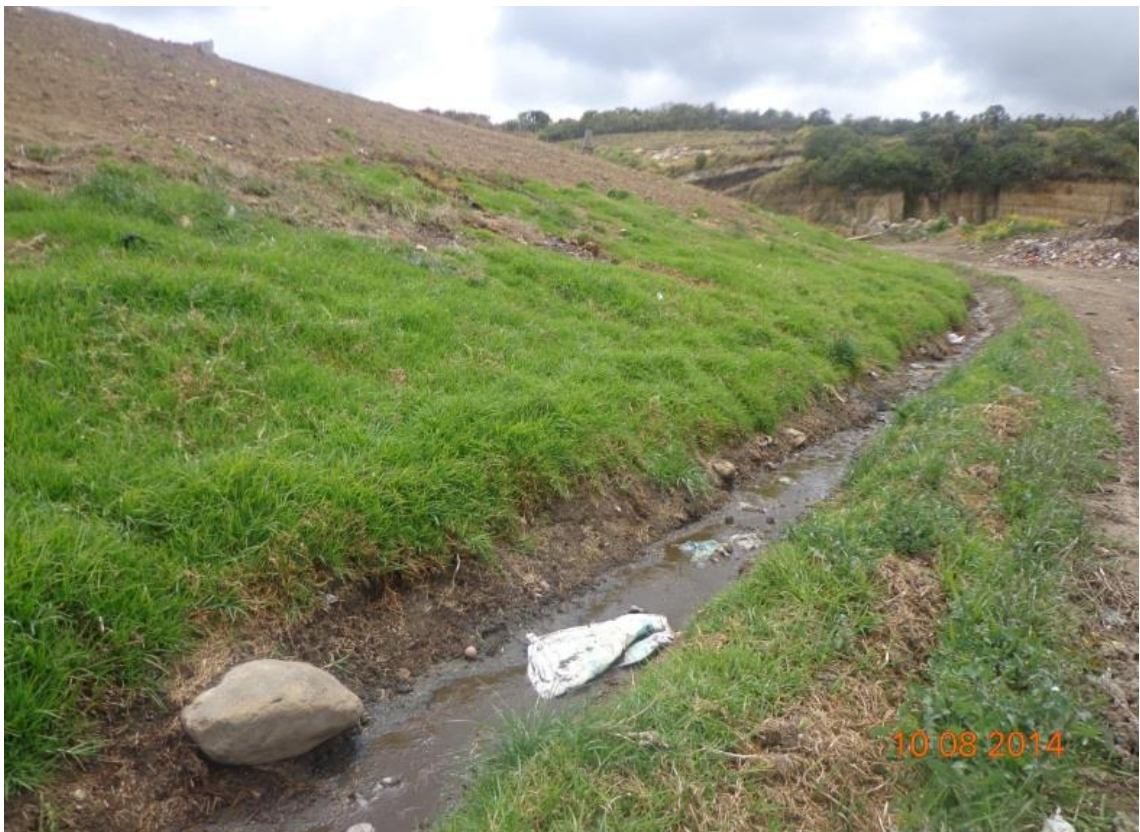
Figura 17. Foto de los canales de lixiviados Daisy Méndez
