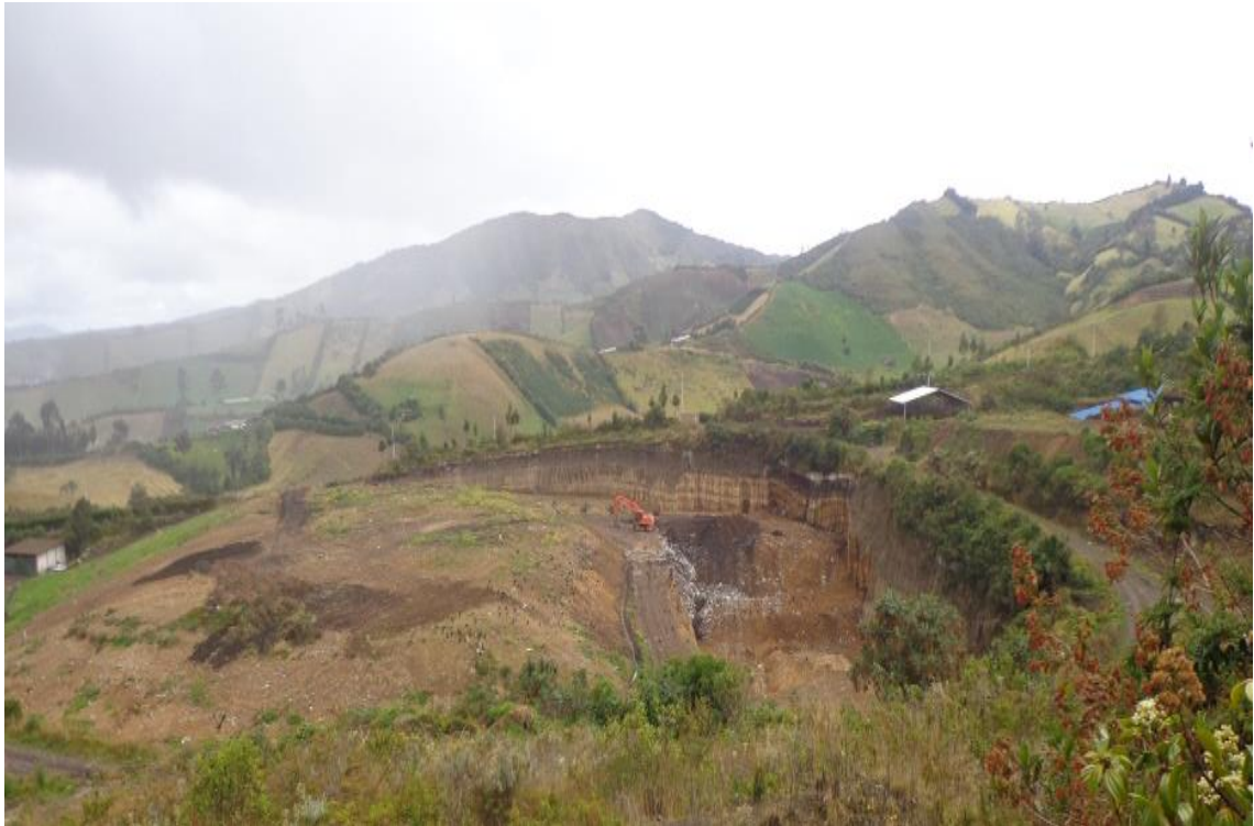
Figura 12. Foto del relleno sanitario
