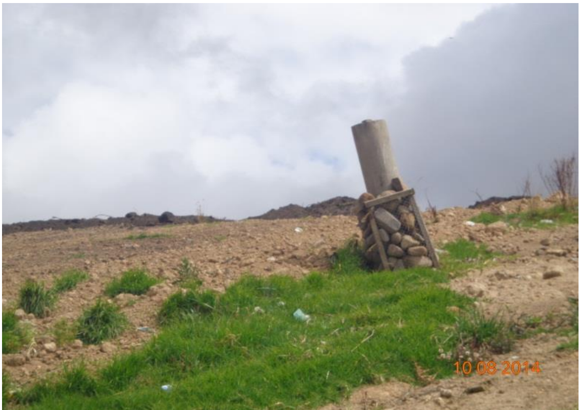
Figura 18. Foto de chimenea para quema de biogás
