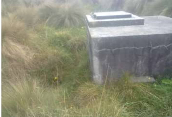
Figura 62. Captación de Agua de consumo Tranca San Luis Baquería Pamba
