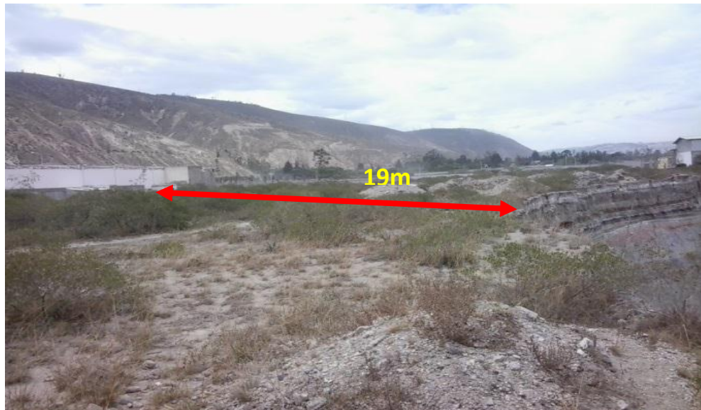
Figura 15. Distancia desde el Conjunto al borde del talud
