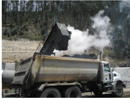
Figura 45. Proceso de carga de material, refinado de asfalto
