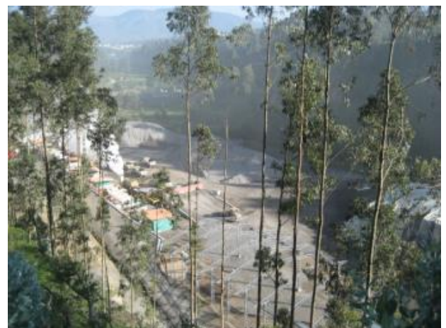
Galpones de acero en construcción en el lugar insitu de explotación de material pétreo
