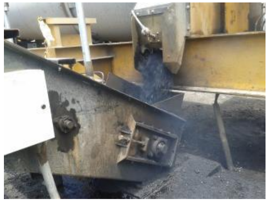
Insumo asfáltico fresco ha altas temperaturas
