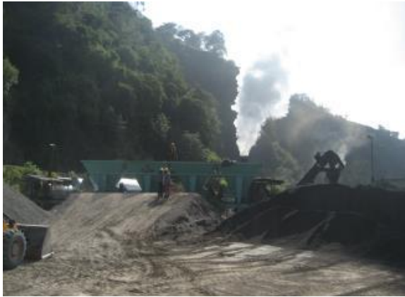
Monitoreo ruido ambiental en planta asfáltica y de hormigón
