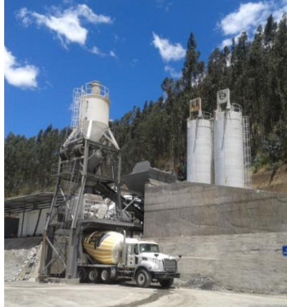
Figura 41. Proceso de Hormigonado
