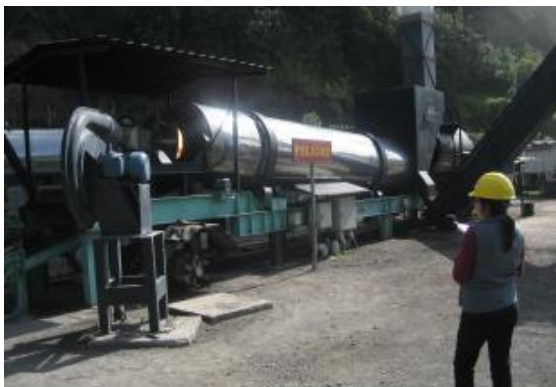
Apoyo técnico en monitoreo de ruido ambiental en la planta asfáltica
