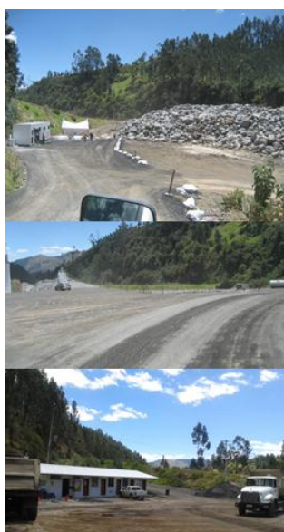
Figura 49. Áreas de: comedor; parqueadero; oficinas y residencia de Panavial S.A.-H.C.C.
