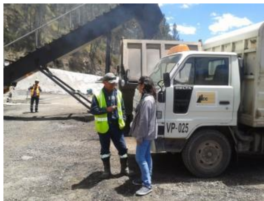
Instrucción del Funcionamiento de la Planta asfáltica
