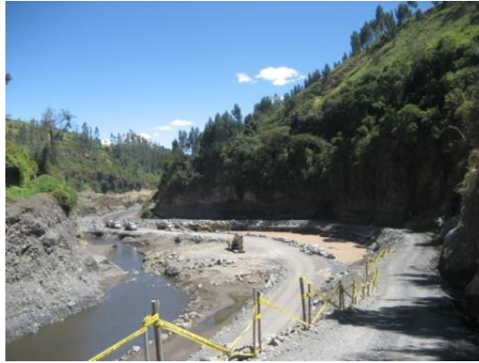
Figura 34. Desbroce en el cauce del río Pita
