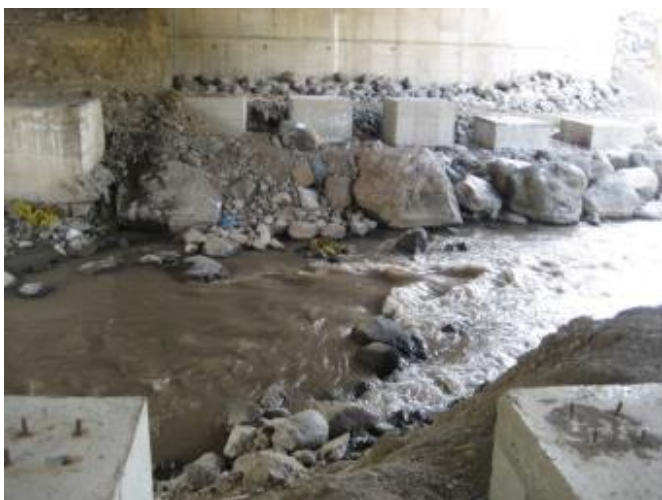
Punto (3) aguas, puente sobre río Pita, actividad minera finalizada
