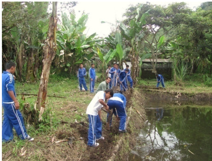
Imagen 8. Adecuación del tanque piscícola
