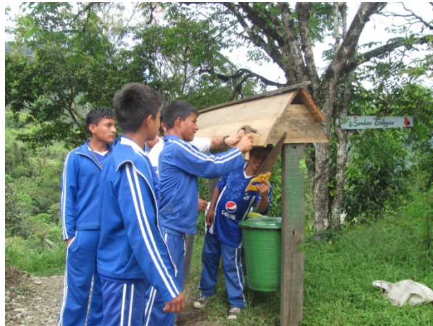
Imagen 10. Adecuación de cubierta para colectores de desechos orgánicos, inorgánicos y no reutilizables.
