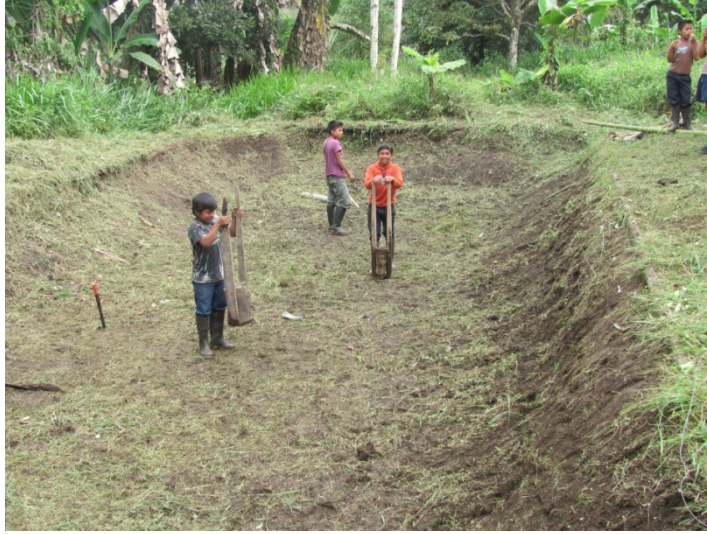
Imagen 7. Compactación del piso en el tanque piscícola.
