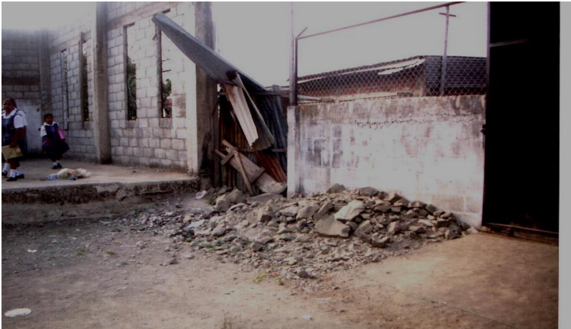
Foto tomada el miércoles 22/07/09 por Lcdo. Eduardo Solórzano, en esta gráfica se observa un montículo de desechos de construcción que está junto al ingreso del establecimiento.
