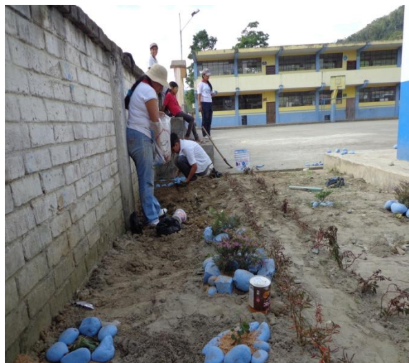
COLOCACIÓN DE LAS PIEDRAS
