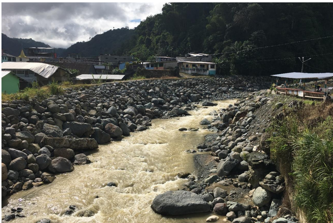
Figura 30. Inexistencia de Muro de concreto.
