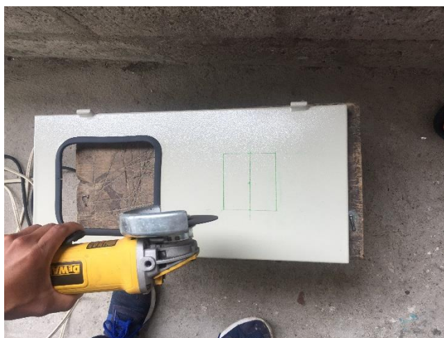
Figura 23. Perforación del gabinete metálico de acuerdo al diseño propuesto.
