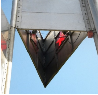
Chorreaduras, cableado suelto, modulo 1 Este - Módulo 2 Sureste. En unión de juntas-soldadas con perfiles delgados
