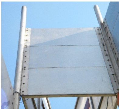
Oxidación en hendidura, pernos, rodelas.
