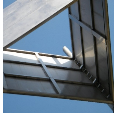
Chorreaduras, cableado suelto, modulo 1 Este - Módulo 2 Sureste. En unión de juntas-soldadas con perfiles delgados
