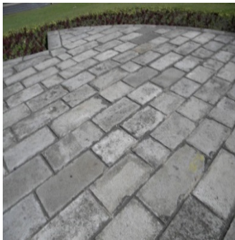
Presencia de acumulación de mugre impregnada en plataforma y canales. (Fotografías. Paulina Guerra C).
