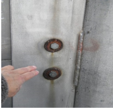
Lado 3 pernos y rodela corroídos ya afectados por corrosión de lluvia.- Desfase de plancha y falta puntos de suelda.
