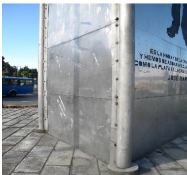
Lado 3 Suroeste. Hay oxidación en pernos que está afectando a los ángulos transversales de sujeción de monumento (Fotografías. Paulina Guerra C).
