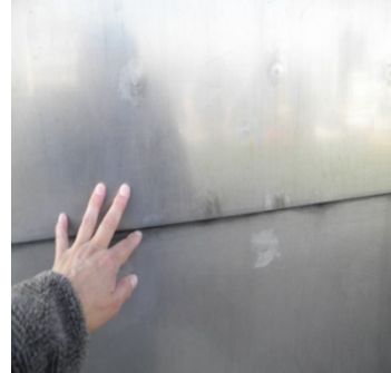
Lado 3 pernos y rodela corroídos ya afectados por corrosión de lluvia.- Desfase de plancha y falta puntos de suelda.
