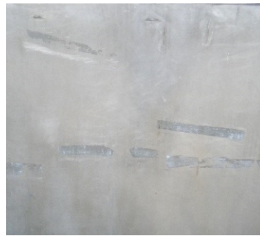
Lado 3, suroeste. Hundimientos por maquinaria pesada, desgaste por disco causado anteriormente y adhesivos.
