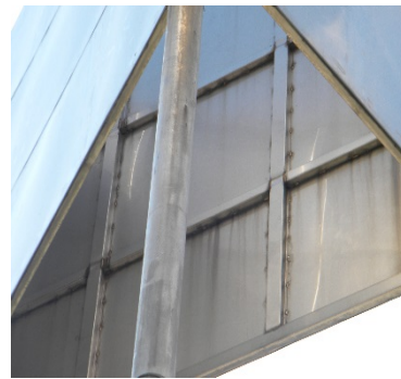
Presenta chorreaduras internas por salpicaduras de soldadura
