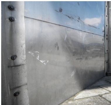
Lado 3, suroeste. Hundimientos por maquinaria pesada, desgaste por disco causado anteriormente y adhesivos.
