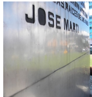
Desfase de plancha producida por el viento.
