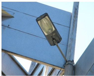
Lámpara halógena blanca –columna.
