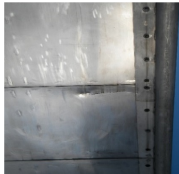
Lado 3 Suroeste. Hay oxidación en pernos que está afectando a los ángulos transversales de sujeción de monumento (Fotografías. Paulina Guerra C).
