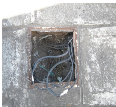
Presencia de acumulación de mugre impregnada en plataforma y canales. (Fotografías. Paulina Guerra C).
