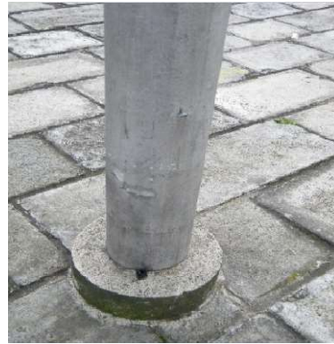
Toma de cableado en columna -Sin caja -Desfase de salida de agua que esta tapada. (Fotografías. Paulina Guerra).
