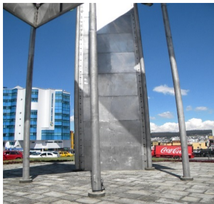
Detalle de 5ta arista (base) con cinco columnas soportantes que descansa sobre plataforma.
