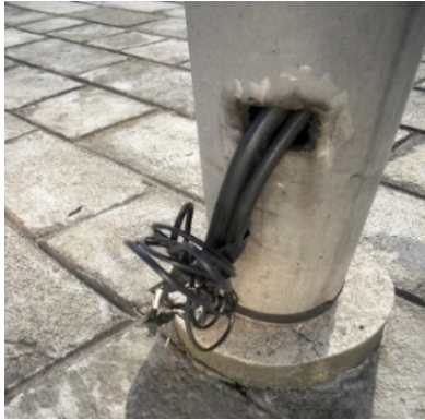
Toma de cableado en columna -Sin caja -Desfase de salida de agua que esta tapada. (Fotografías. Paulina Guerra).
