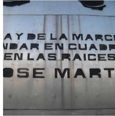
Halos quemados en plancha por soldadura.
