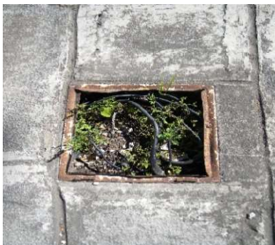
Presencia de acumulación de mugre impregnada en plataforma y canales. (Fotografías. Paulina Guerra C).
