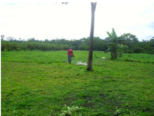
Limpieza del terreno
