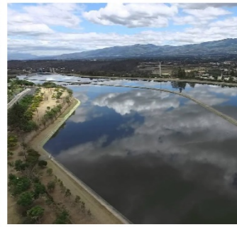
Central Hidroeléctrica Cumbayá
