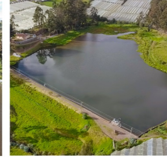
Central Hidroeléctrica Los Chillos
