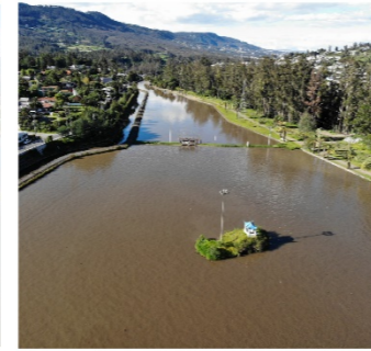
Central Hidroeléctrica Guangopolo
