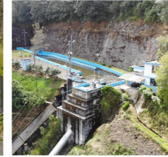
Central Hidroeléctrica Pasochoa
