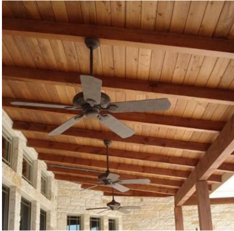
Imagen No 61 Revestimiento de Techo de Madera Fuente: http://www.actiweb.es/madnea/productos.html
