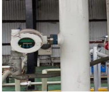
Figura 9 Detector de BS&W Unidad LACT Estación Paraíso
