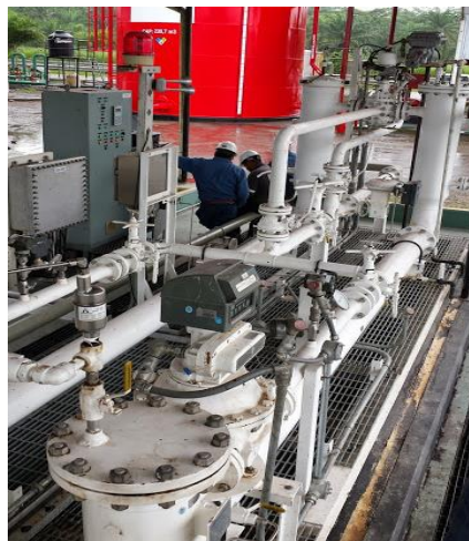
Figura 20 Probador Unidad LACT Estación Paraíso
