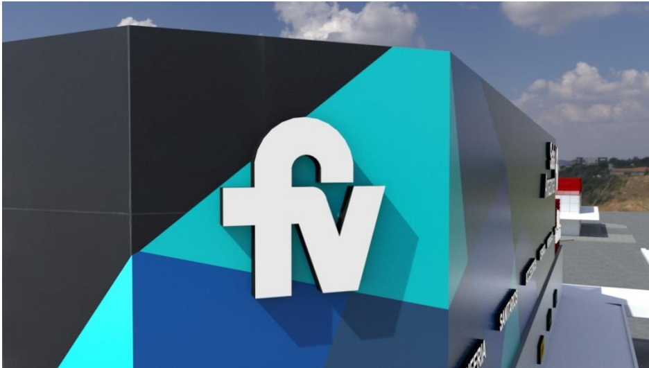
Ilustración 102: Fachada F.V. alucobon y vinil adhesivo Fuente: Propia
