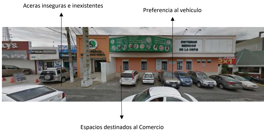
Ilustración 64: Estado Actual Edificación
