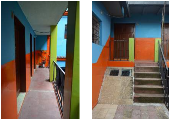
Anexo 3. Fotografías del estado actual
