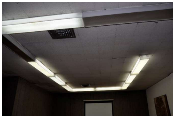
Figura 39 Cielo falso de Armstrong. Fotografía tomada por Esteban Sánchez
