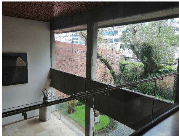
Figura 32 Ventanas fachada frontal. Fotografía tomada por Esteban Sánchez
