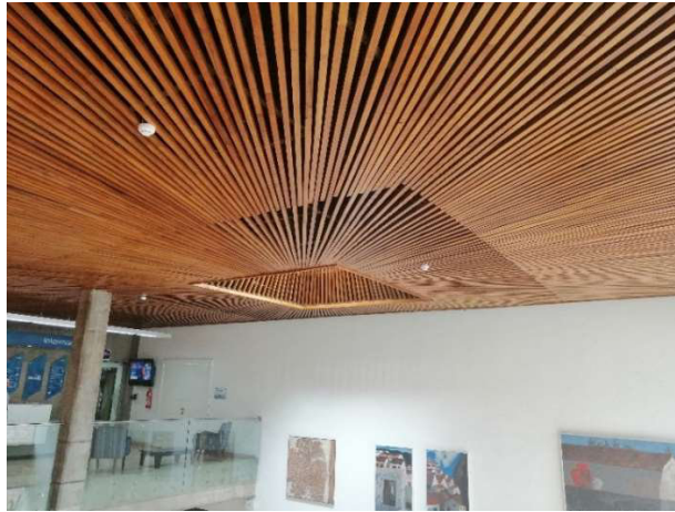
Figura 38 Cielo falso de madera. Fotografía tomada por Esteban Sánchez
