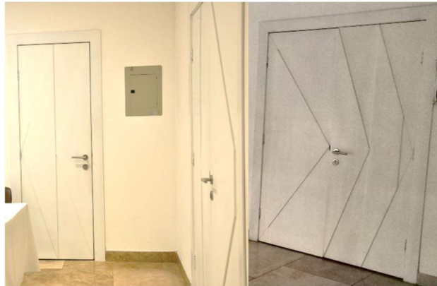
Figura 31 Puertas al interior del edificio. Fotografía tomada por Esteban Sánchez
