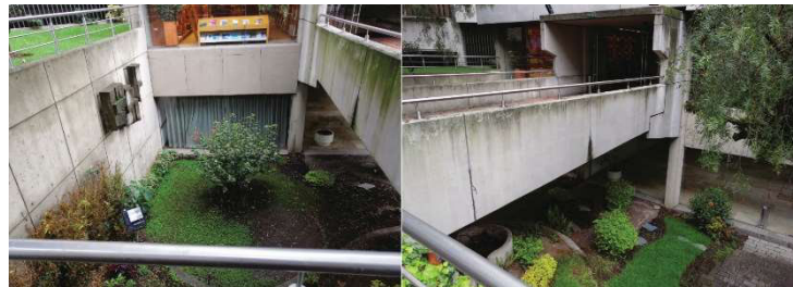
Figura 29 Retiro frontal deprimido. Fotografías tomadas por Esteban Sánchez.
