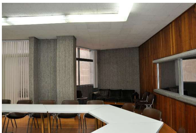
Figura 41. Revestimientos interiores. Fotografía tomada por Esteban Sánchez
