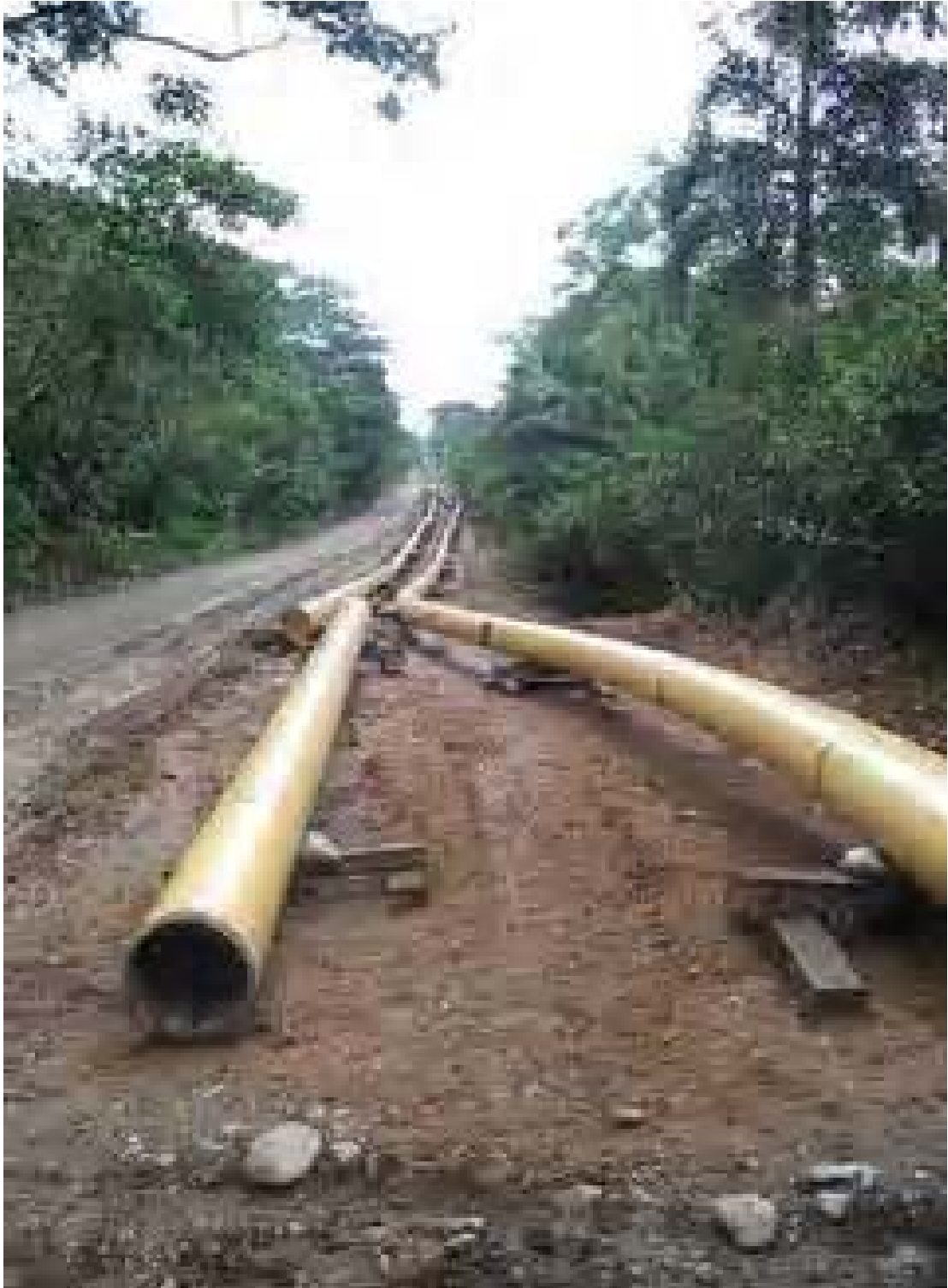
Foto 06. Tendido de Tuberías en el Bloque 15 – Complejo ILYP
