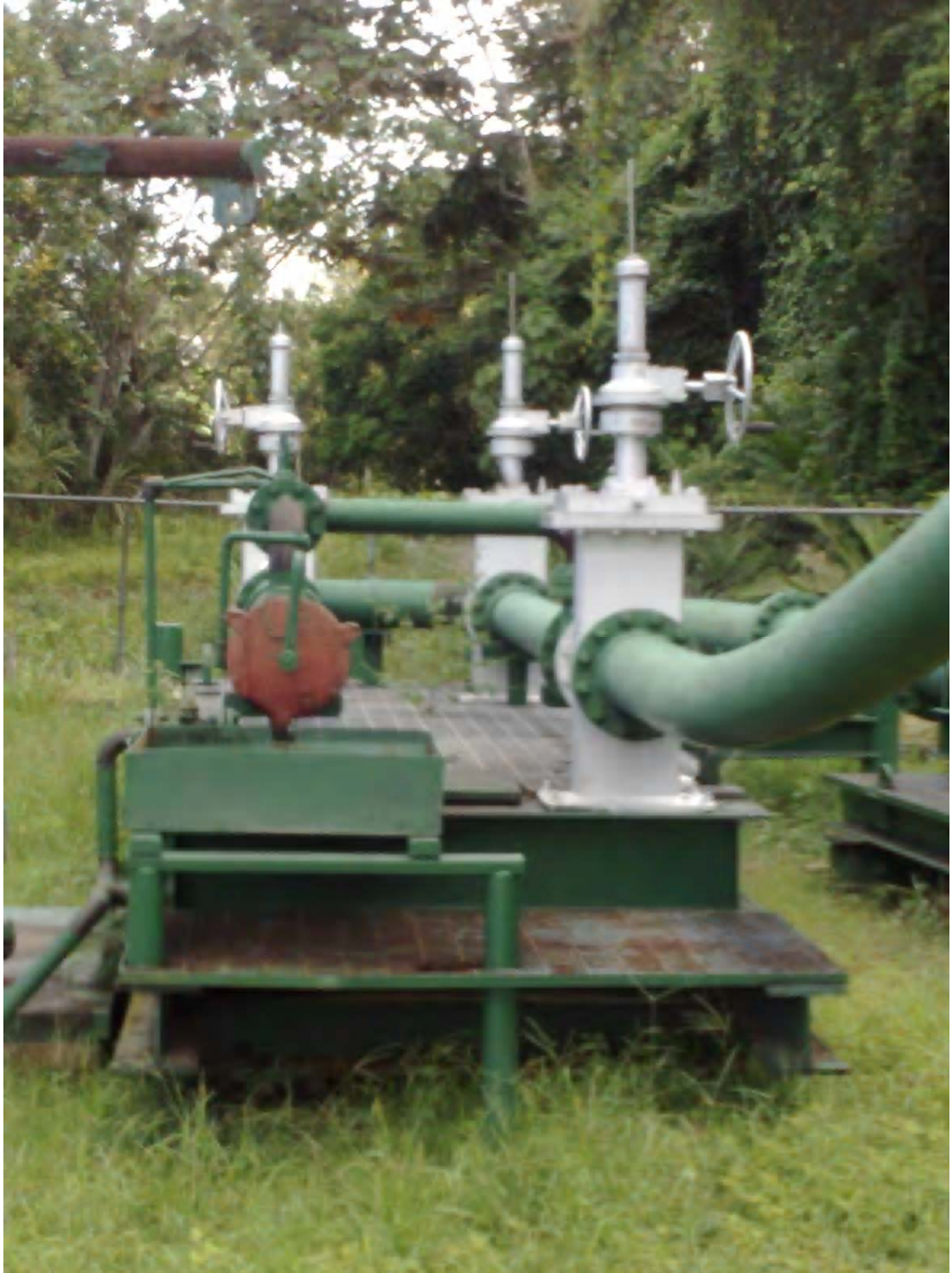
Foto 21. Unidad de Recepción de Raspatubos (Marranera de Recepción)
