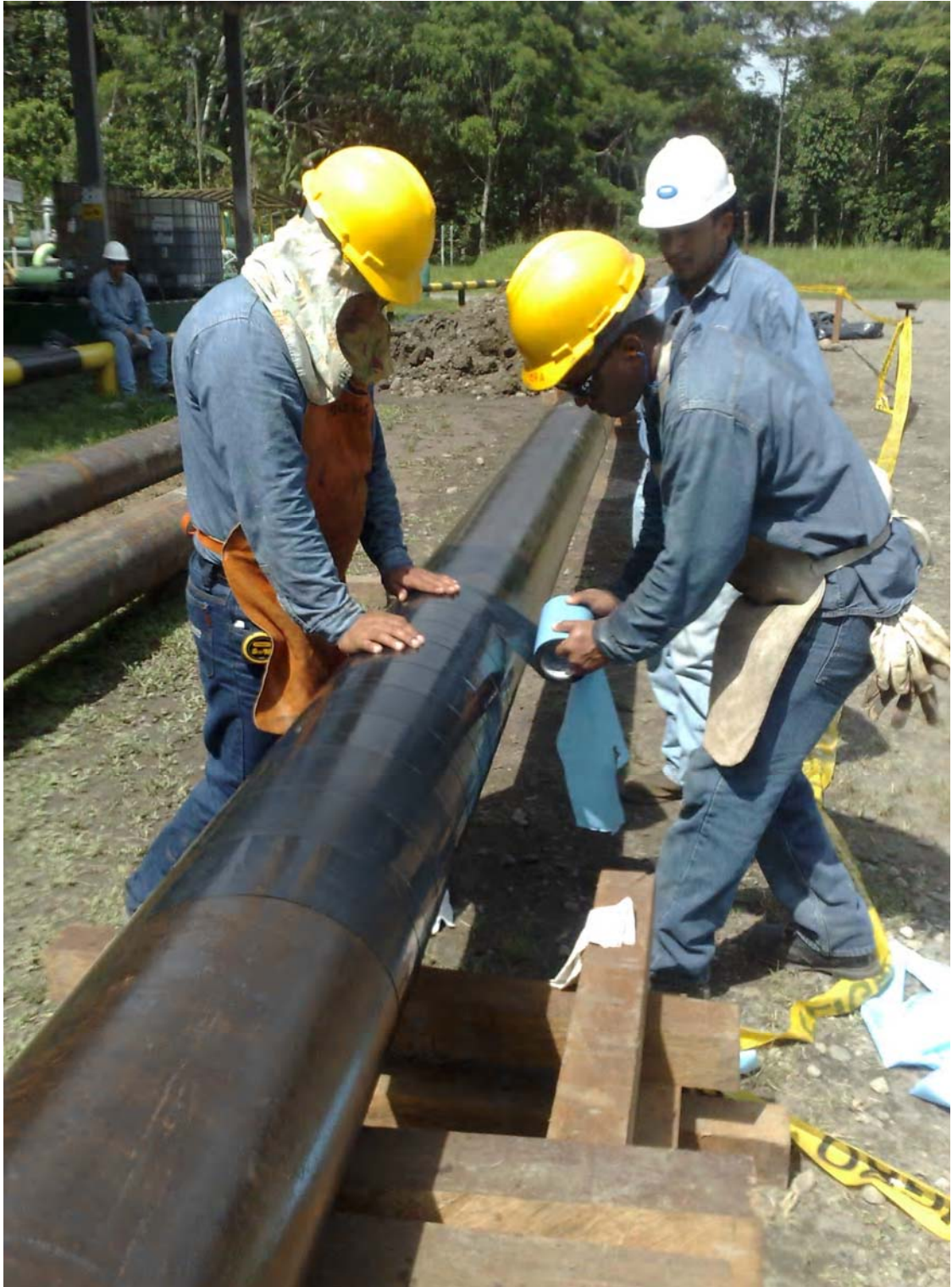
Foto 03. Recubrimiento Externo de la Tubería con cinta anticorrosiva Bloque 15
