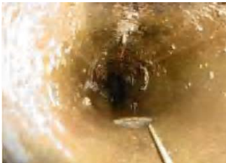
Foto 11. Intervención después de la Limpieza Mecánica con Raspatubos
