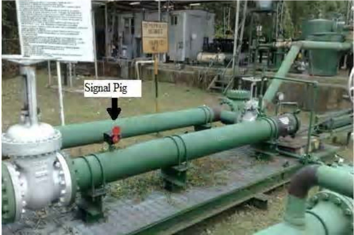
Foto 22. Ubicación del Signal Pig en la Marranera
