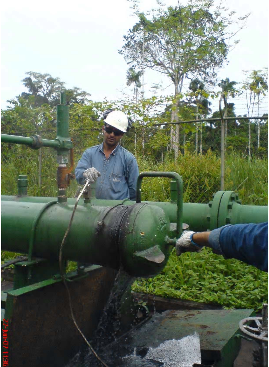
Foto 23. Procedimiento antes de Rescatar al Raspatubos en la Marranera
