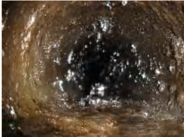
Foto 10. Intervención antes de la Limpieza Mecánica con Raspatubos
