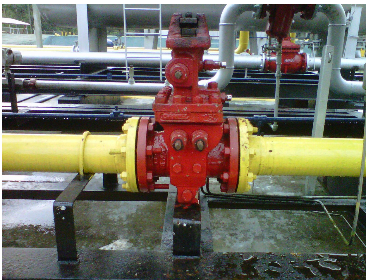
Figura 3.9 - Porta Placa Orificio (Fitting)
