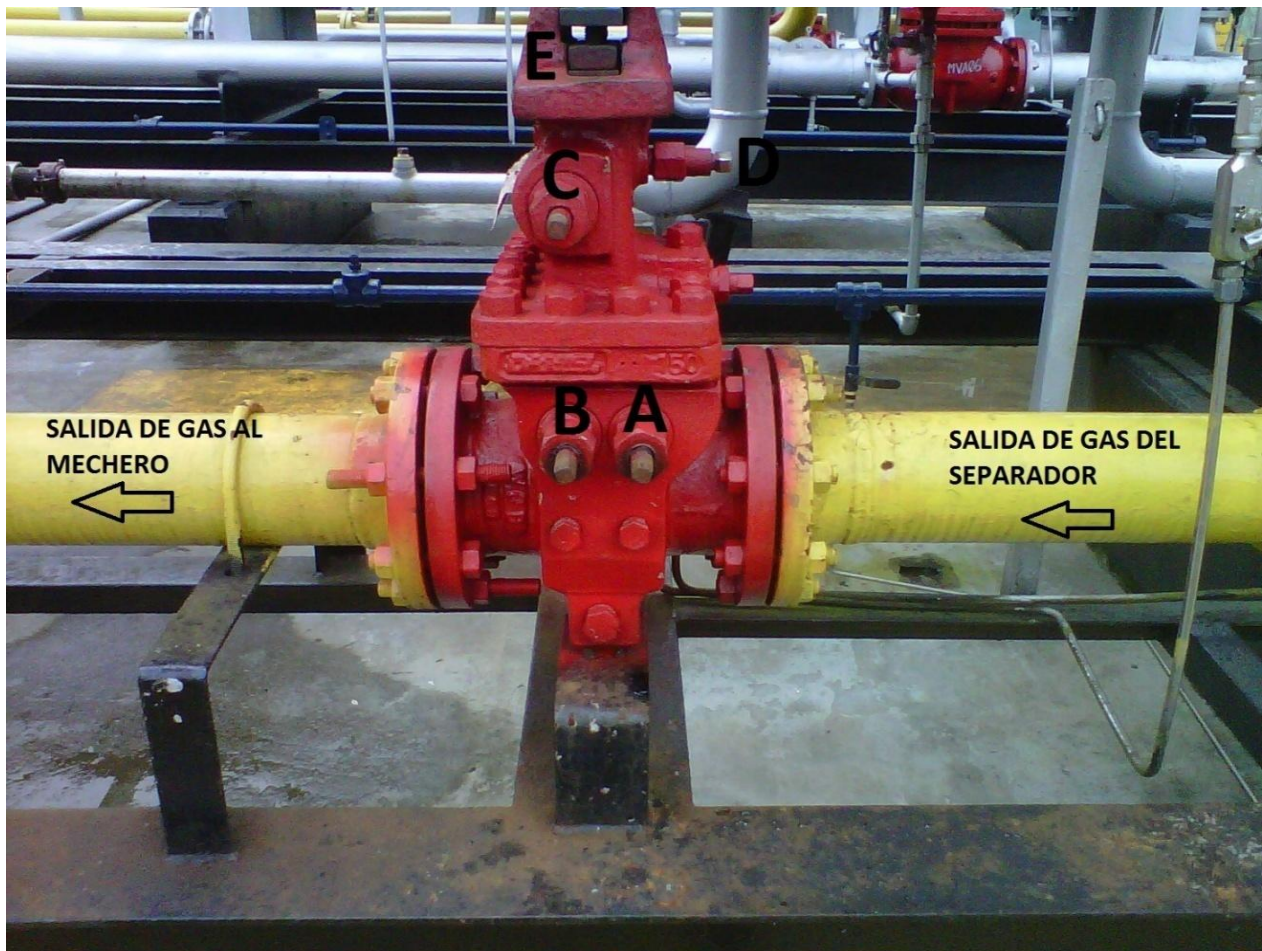
Figura 3.10 - Componentes del Fitting
