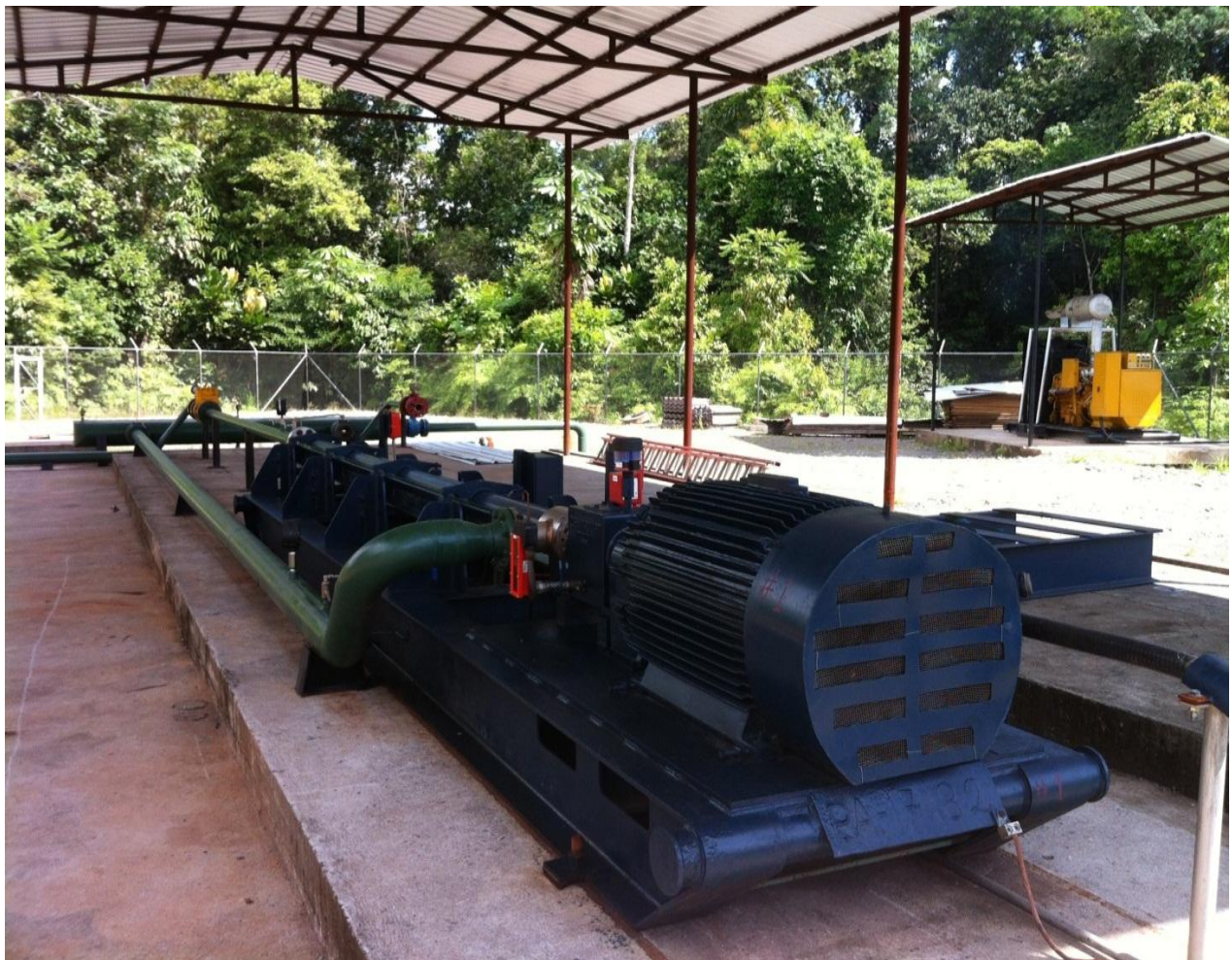
Figura 3.51 –HPS (Sistema de Bombeo Horizontal)
