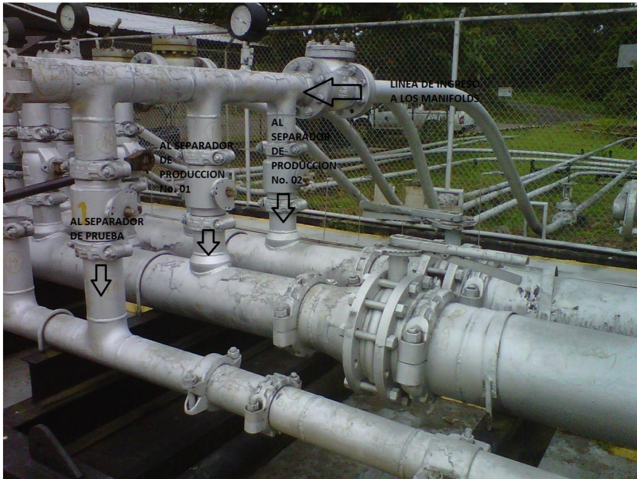
Figura 3.2 - Múltiple (manifold)
