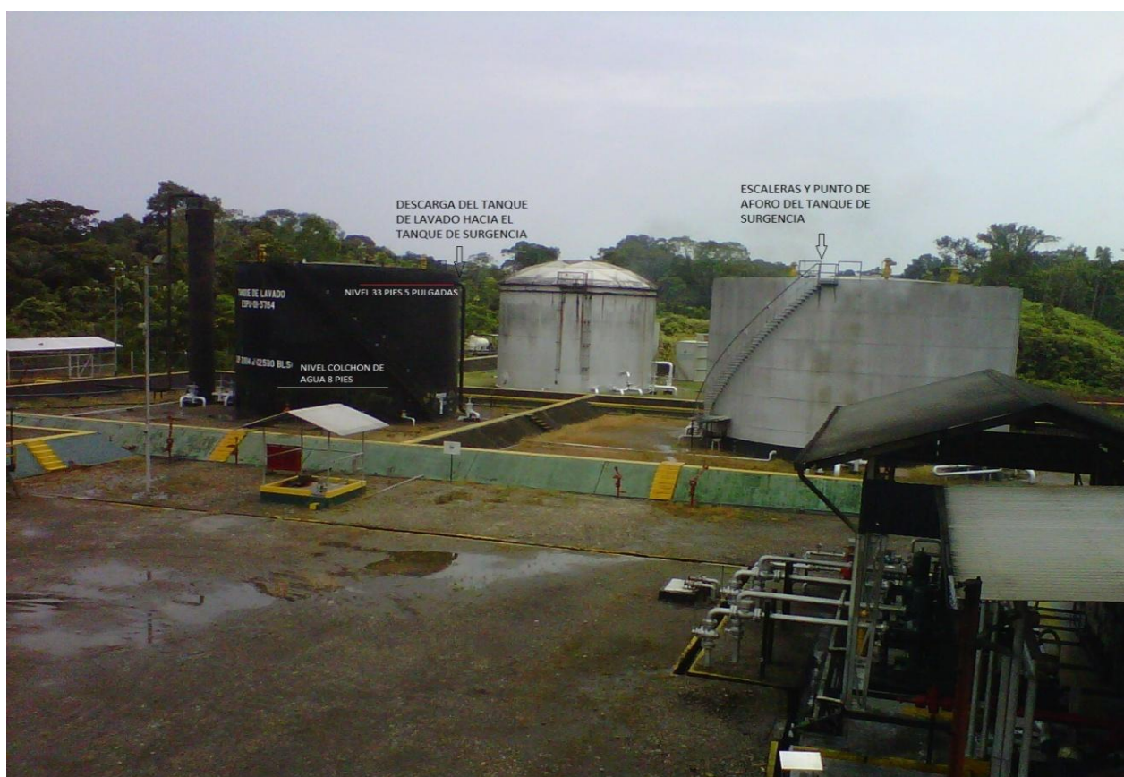
Figura 3.19 - Tanque de Lavado y Tanque de Surgencia
