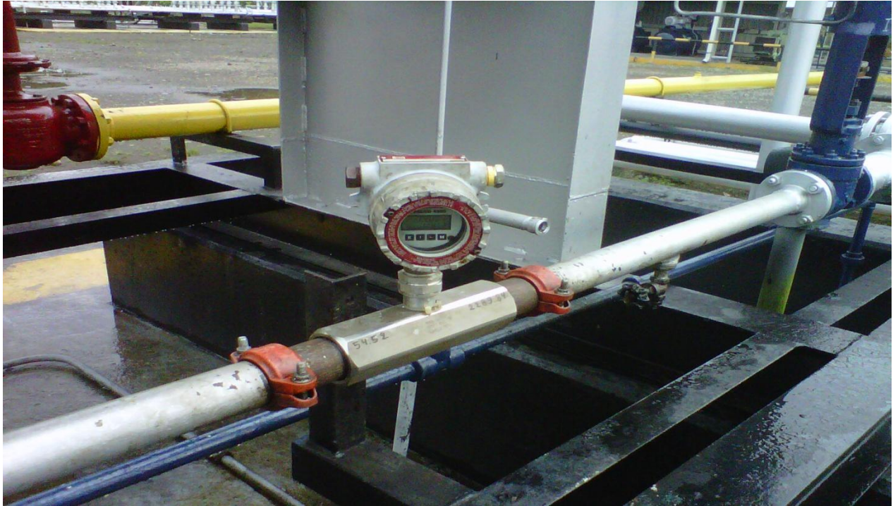
Figura 3.15 – Flujómetro de Turbina para líquidos (Axial)
