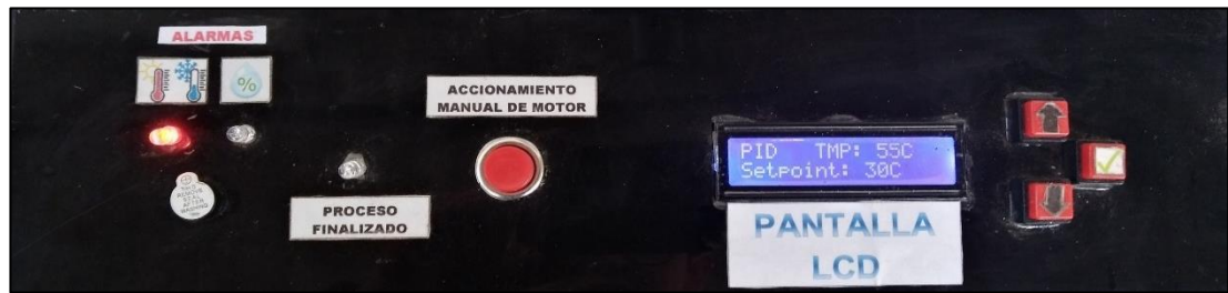
Figura 64. Panel de table alarma de temperatura
