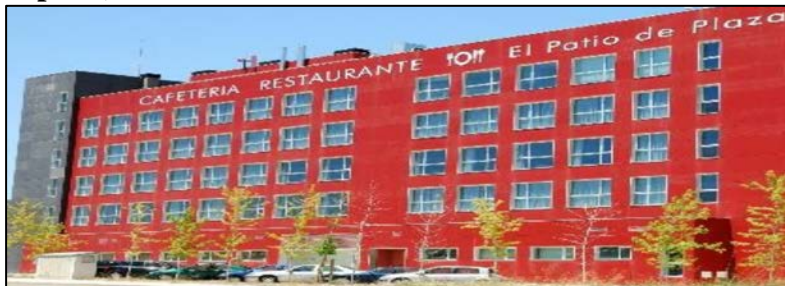
Figura 1.9. Cafetería Restaurante El Patio Plaza (Plataforma Logística Zaragoza, España)
