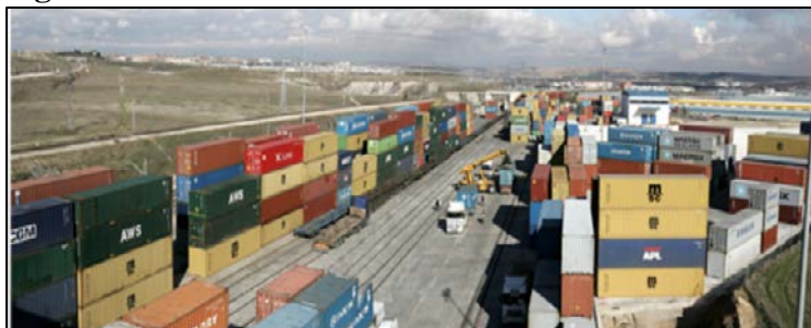
Figura 1.4. Puerto Seco Madrid
