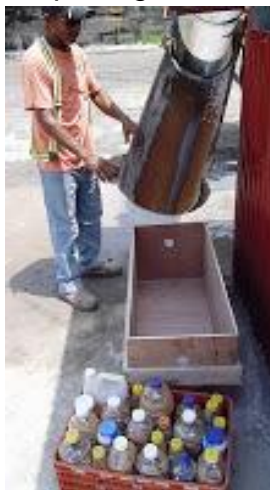
Fig. 28. Encofrado de las baterías (López M. , 2016).
