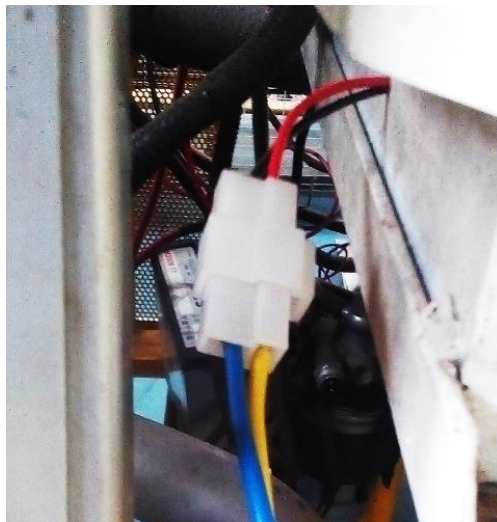
Figura 89. Conexión entre circuito de control y banco de pruebas
