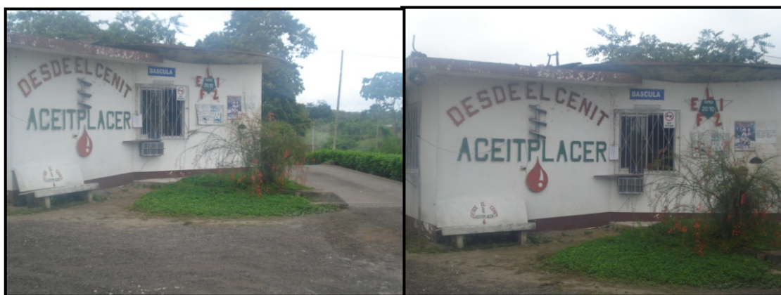
Foto N° 4. Parte Delantera de la Extractora “ACEITPLACER”.
