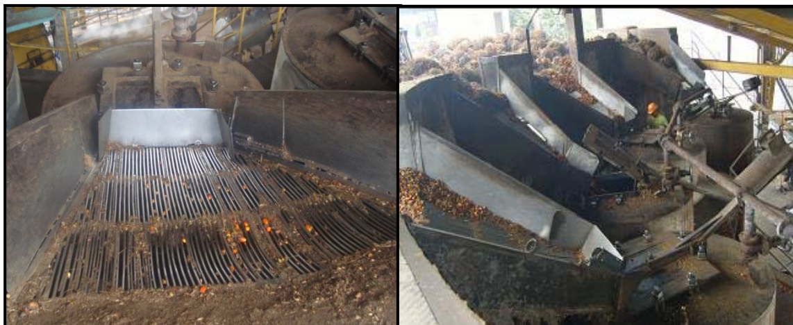
Foto N.º 7 Esterilizadores verticales (Autoclaves) de ACEITPLACER.
