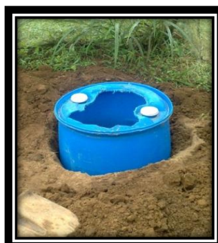
Figura 9 Colocación de los tanques reservorios
