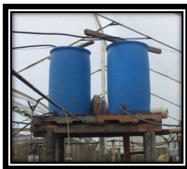
Figura 8 Colocación de los tanques elevados al soporte de madera
