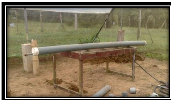
Figura 2 Construcción de la estructura de madera para el sistema NFT.
