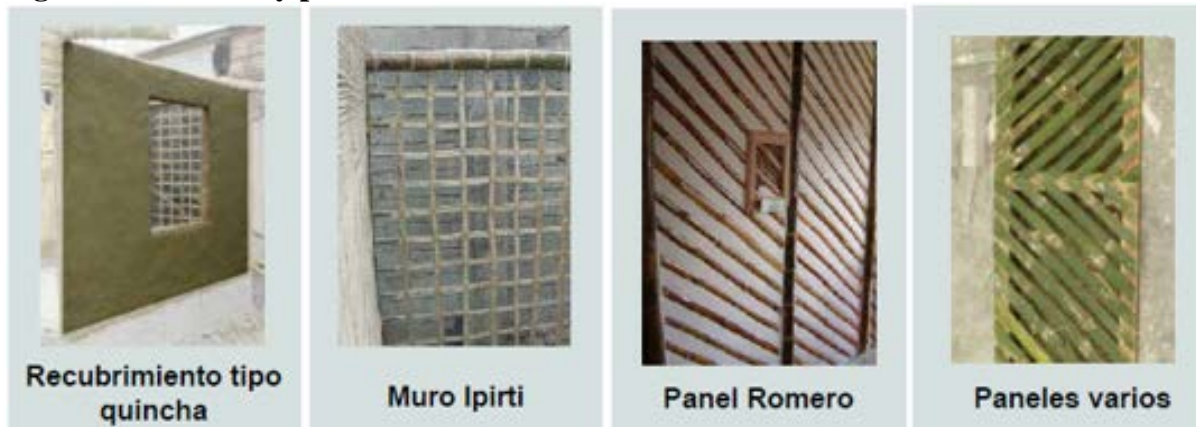
Figura 3.12. Muros y paneles no estructurales
