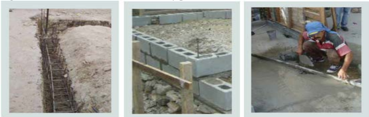
Figura 3.8. Cimentación, sobrecimientos y piso
