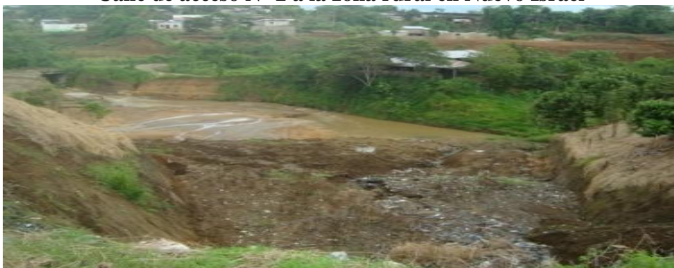
Fotografía N° 21 Calle de acceso N° 2 a la zona rural en Nuevo Israel
