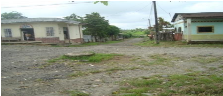
Fotografía N°20 Calle de acceso N° 1 a la zona rural en Nuevo Israel
