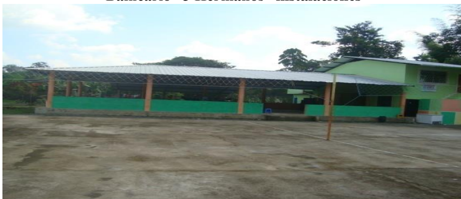
Fotografía N° 17 Balneario “3 Hermanos” instalaciones
