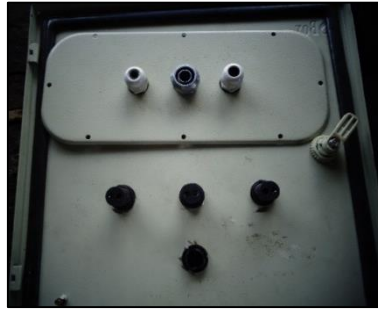
Figura N° 82 Perforaciones y ubicación de prensaestopas
