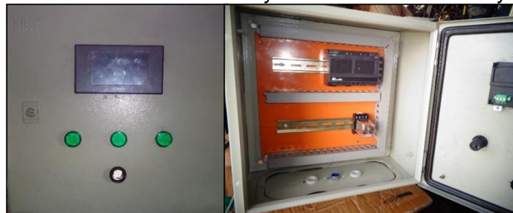
Figura N° 83 Instalación del HMI y luces de señalización y canaletes
