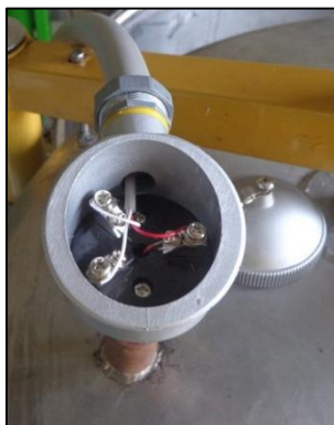
Figura N° 84 Conexión del Sensor de Temperatura
