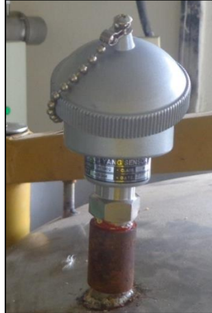
Figura N° 33 Pt100 con cabezal de conexión
