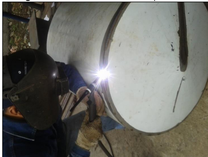
Figura N° 66 Soldadura de la tapa inferior
