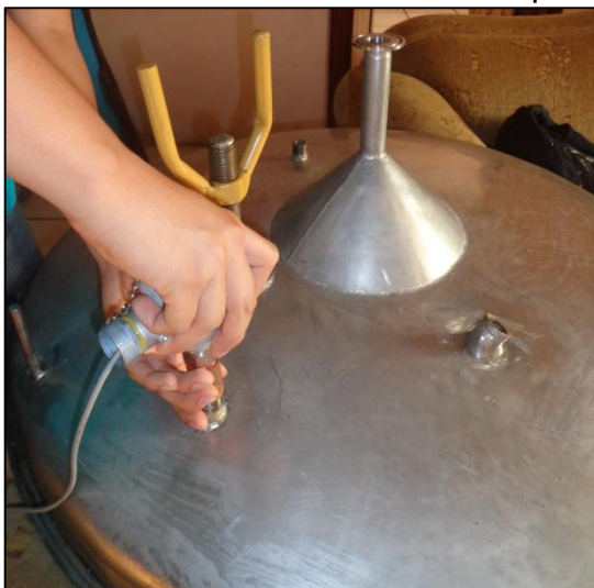
Figura N° 80 Instalación del sensor de temperatura Pt-100
